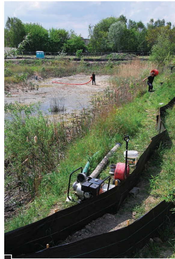
Wypompowywanie wody 12 maja. Widać też ogrodzenia zabezpieczające teren przed migracją żab fot. Piotr P. Ruszkowski
