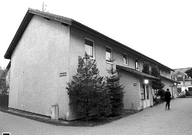
Budynek komunalny na zamkniętym osiedlu deweloperskim przy ul. Rydla 27 G. Trzy z ośmiu mieszkań w tym domu, o powierzchniach ponad 50 m 2 , miasto sprzedaje już w tym roku. Za jaką kwotę, nie wiadomo! fot. Piotr P. Ruskowski
