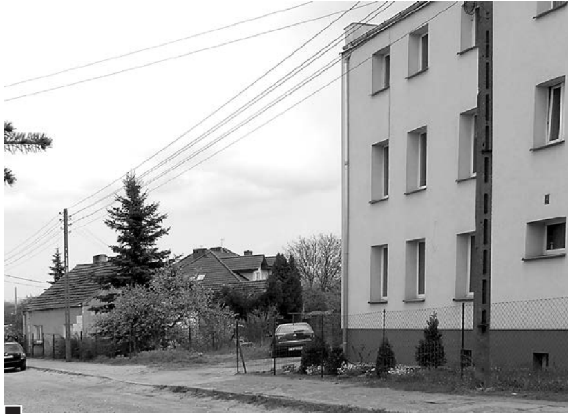
Miejska nieruchomość przy ul. Łącznej 4. Z prawej gruntownie odremontowany w ostatnich latach budynek sprzed 1945 r., z lewej – miejsce na nowy dom komunalny (obecnie ogródki) fot. Hanna Siatka
