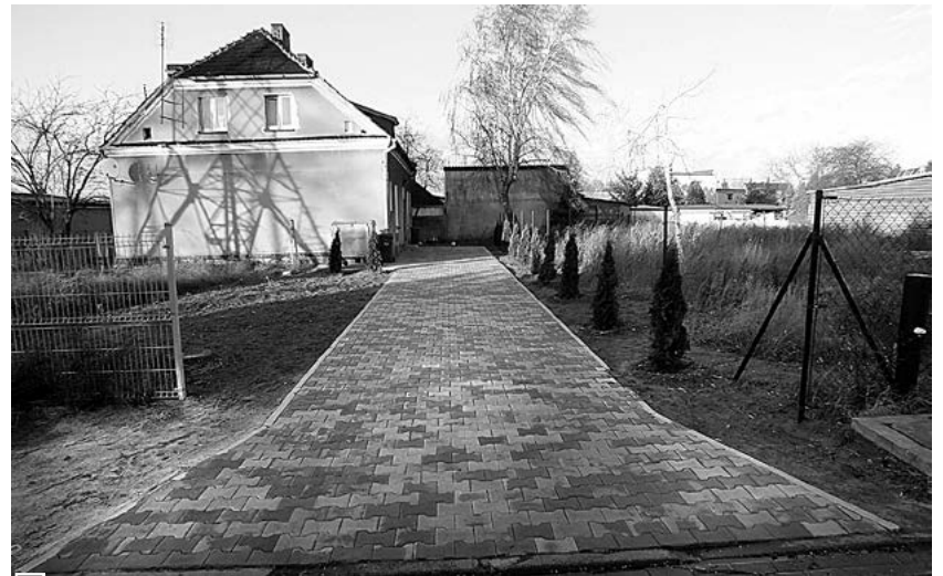
Budynek komunalny przy ul. Armii Poznań 111 – willa z 1932 r. z czterema mieszkaniami. Wymaga prac remontowych i naprawczych (m.in. wymiana drzwi wejściowych i niektórych okien), opisaliśmy ją wielokrotnie, m.in. w 2014 r. w marcu na str. 26 („Nie te scenariusze”) i w kwietniu, str. 22 („Gospodarskim okiem”). W 2015 r. uporządkowano teren przy budynku (położono chodnik i zasadzono zieleń), wydzielając działkę do sprzedaży (z prawej) fot. Hanna Siatka
