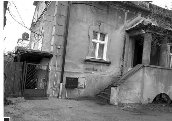
Pierwsza siedziba Avanti – suterena zabytkowej willi przy ul. Okrzei 67 (skrzyżowanie z Brzechwy) – wejście z lewej
