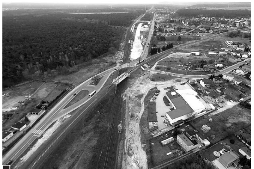
Od lewej – ul. Armii Poznań (Droga wojewódzka 430) z pętlą autobusową, dalej – wpadająca do niej ul. Kręta (z prawej), nad którą zabytkowy, ceglany wiadukt kolejowej linii do Wolsztyna, obok po lewej – ta sama linia z wiaduktem, pod którym torowisko linii do Wrocławia. Jasna plama od góry zdjęcia to prace związane z bezkolizyjnym przejazdem trasy 430 fot. Rafał Wojtyniak
