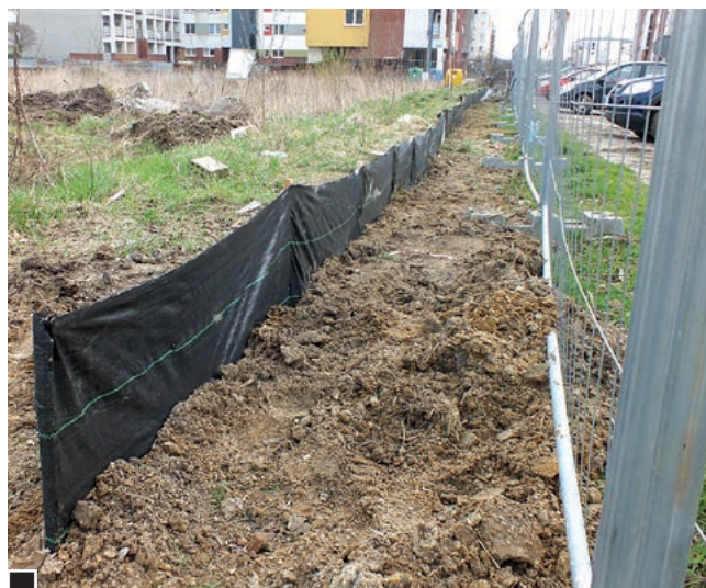
Specjalne zabezpieczenie przed przedostawaniem się do stawu kolejnych żab – płotek z folii, wybudowany pomiędzy ogrodzeniem placu budowy a zbiornikiem fot. Hanna Siatka
