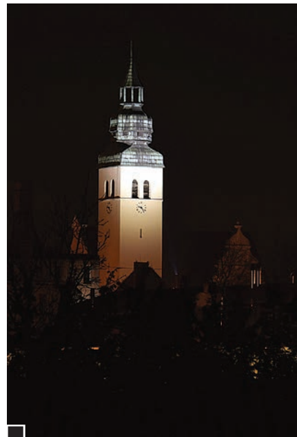
Wieża kościelna widoczna z pobliskiej ul. Lipowej fot. Rafał Wojtyniak
