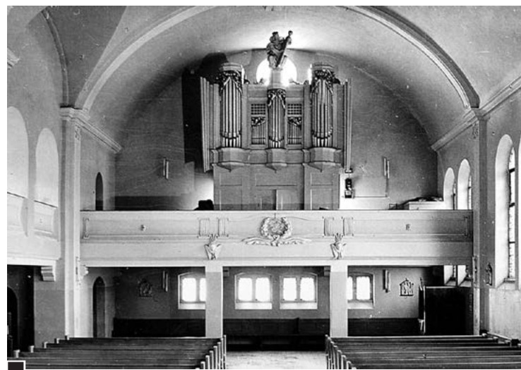
Wnętrze kościoła w latach 60. – po gruntownym remoncie w 1951 r. ze zbiorów WL
