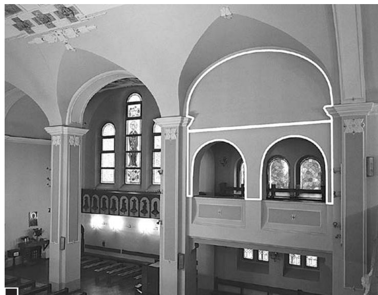
Wnętrze kościoła św. Barbary – stan obecny. Na potrzeby wyjaśnienia, na zdjęciu białym konturem specjalnie oznaczono wypełnienie łuku podczas remontu kościoła w 1951 r. oraz lokalizację nieużywanego pomieszczenia nad chórem bocznym (pokazane obok) fot. Rafał Wojtyniak
