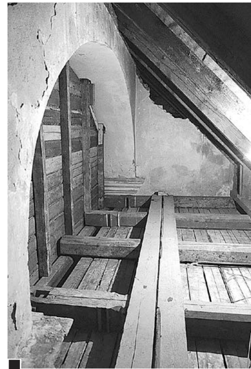
Niedostępne, nieużytkowe pomieszczenie nad bocznym chórem. Rzeźbione belki (z pierwotnego kościoła, wskazane na archiwalnym zdjęciu) stanowiące belki stropowe (poziome), do których przybito deski sufitowe chóru bocznego. Po lewej – wypełnienie łuku pomiędzy filarami. Na środku – deski przeznaczone do bezpiecznego poruszania się po pomieszczeniu fot. Rafał Wojtyniak
