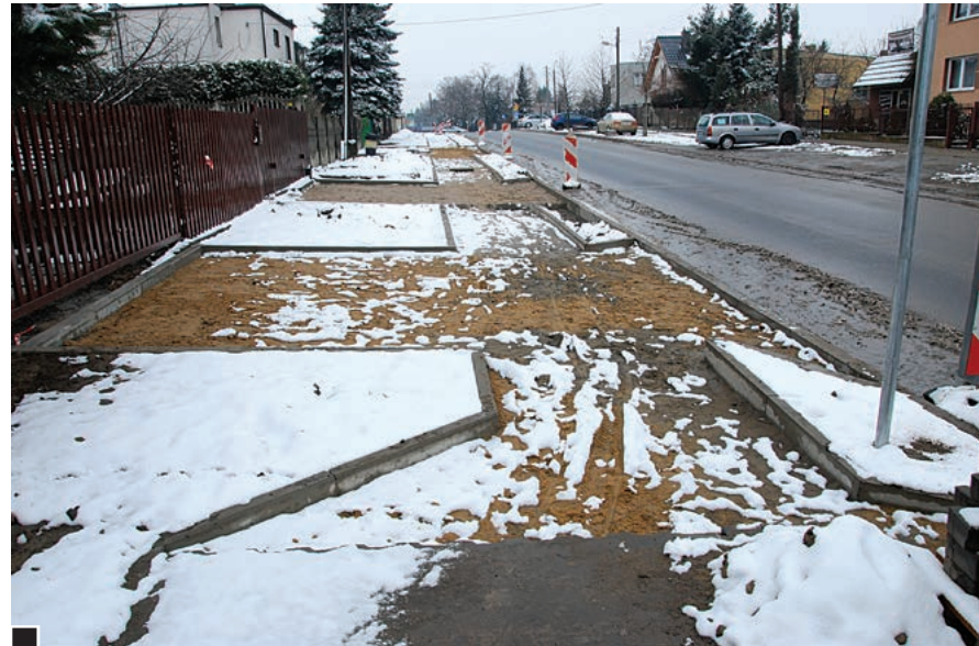
Od wschodu – na ul. Wschodniej, na przedłużeniu Wojska Polskiego, zaczęto porządkować szeroki, ponad 5-metrowy pas zieleni. Ułożono krawężniki chodnika i wjazdów na posesje fot. Piotr P. Ruskowski
