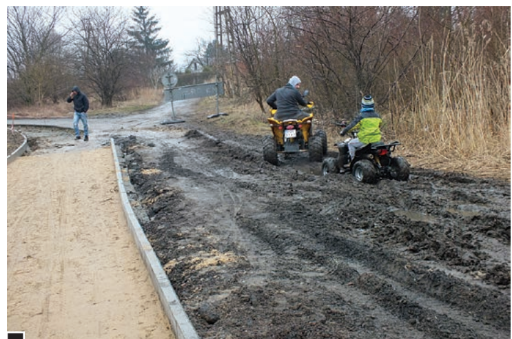
Z błotnistej, trudnego do przebycia terenu wzdłuż przyszłej ścieżki pieszo-rowerowej chętnie korzystają amatorzy quadów, w tym przypadku rodzinnie fot. Hanna Siatka
