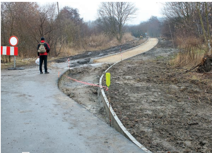
Miejsce, w którym stykają się luboński odcinek ścieżki z poznańskim – widok od ul. Świerczewskiej. W głębi – nieutwardzony jeszcze luboński fragment w kierunku ul. Niezłomnych fot. Hanna Siatka
