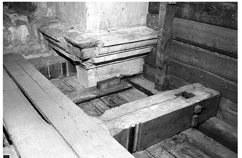
Głowica filaru przy chórze bocznym z profilowanym gzymsem, w którą wmontowano belki. Po prawej widoczny kwadratowy otwór w poziomej, rzeźbionej, malowanej barokową zielenią belce kościoła ewangelickiego, w który wchodziła pionowa belka do sklepienia (patrz zdjęcie archiwalne) fot. Rafał Wojtyniak
