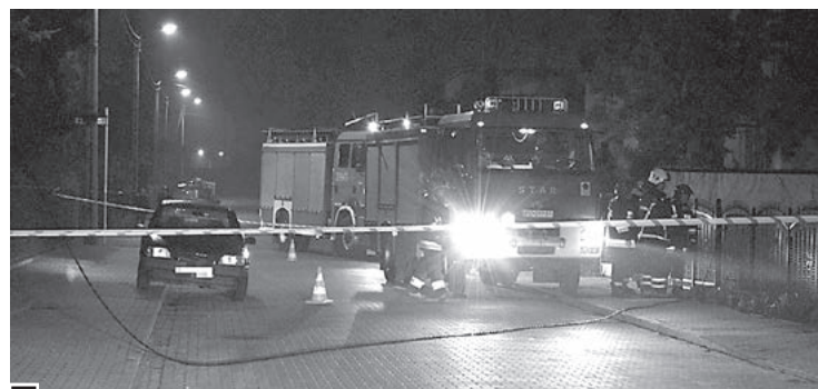
Urywany, leżący w poprzek drogi kabel energetyczny fot. Rafał Wojtyniak
