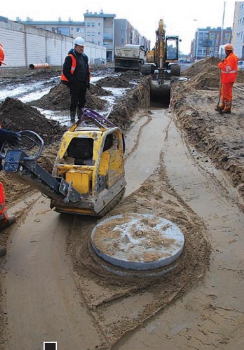
Od zachodu – układanie kanalizacji deszczowej i studni rewizyjnych w pasie ul. Wschodniej na wysokości bloków 27 i 28. Warunki atmosferyczne sprzyjają pracom. Jak dotąd nie ma też kłopotów z wodami gruntowymi fot. Piotr P. Ruskowski
