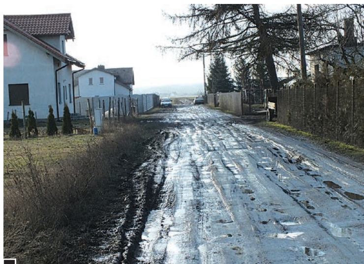
Rozjeżdżona przez samochody, błotnista ul. Wirowska, bez chodnika i możliwości dojścia do posesji. Po obu stronach – zabudowania. Wyraźnie widać brak możliwości poszerzenia drogi do szerokości 10 m, przewidzianej w planie miejscowym. W głębi – pola, a za nimi ul. Polna i Wiry fot. Hanna Siatka
