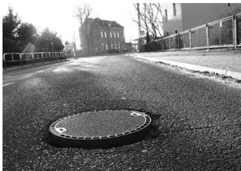
Studzienka kanalizacyjna w ul. ks. Streicha z ostrymi krawężnikami stanowi duże niebezpieczeństwo dla przejeżdżających tędy aut fot. Paweł Wolniewicz
