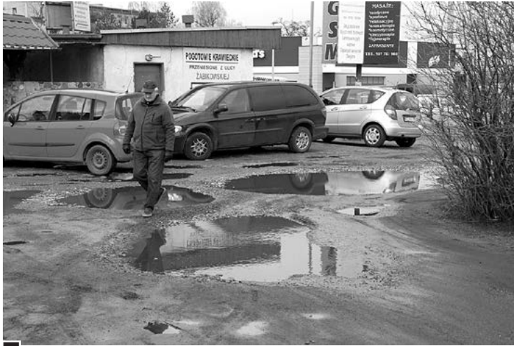
Przy wylocie dzikiej drogi w ul. Powstańców Wlkp. – parkujące byle jak samochody, kałuże i nierówności, po których trudno jeździć czy chodzić fot. Piotr P. Ruszkowski
