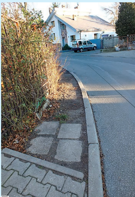
Pieszy poruszający się zwężonym fragmentem „chodnika” na łuku ul. Lipowej jest narażony na niebezpieczeństwo. Jak mają się tędy przemieszczać inwalidzi lub wózki? fot. Hanna Siatka
