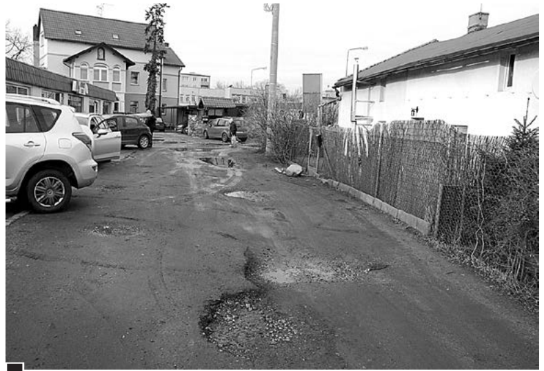
Zwulkanizowany poprez asfaltowy, szlaka i tłuczeń podniosły poziom gruntu, powodując spływ wód deszczowych i zanieczyszczanie sąsiednich posesji. Powstające wciąż na nowo dziury trudno wyrównywać. Jedynym wyjściem jest chyba zebranie górnej warstwy drogi, wyłożenie jednolitym strukturalnie materiałem oraz wpisanie jej w harmonogram równania dróg miejskich (przynajmniej czasowo) fot. Piotr P. Ruszkowski
