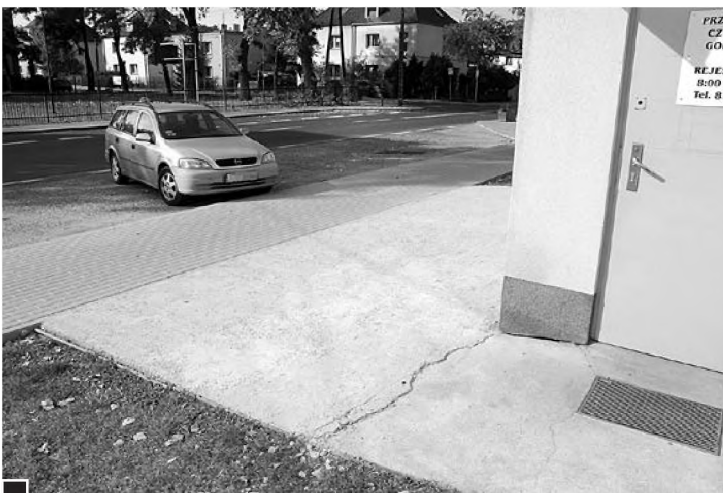
Nową, dodatkową wylewką betonową, po publikacji w sierpniowych „WL” spowodowano likwidację powstałego po modernizacji przystanku i jego otoczenia progu w chodniku do przychodni lekarskich przy ul. ks. Streicha fot. Piotr P. Ruskowski
