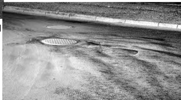
Przy płaskim nocnym świetle reflektorów samochodowych wyraźnie widać pofałdowanie asfaltu, wokół wlezu kanalizacyjnego przy skrzyżowaniu ul. Okrzei z ul. Pułaskiego. Strzałkami wskazaliśmy wypełnienia sporych zapadnięć asfaltu, jakie powstały podczas lipcowych ulew opisywanych w sierpniowych „WL” fot. Piotr P. Ruskowski
