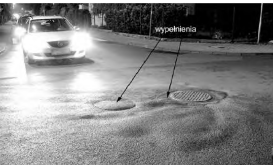
Przy płaskim nocnym świetle reflektorów samochodowych wyraźnie widać pofałdowanie asfaltu, wokół wlezu kanalizacyjnego przy skrzyżowaniu ul. Okrzei z ul. Pułaskiego. Strzałkami wskazaliśmy wypełnienia sporych zapadnięć asfaltu, jakie powstały podczas lipcowych ulew opisywanych w sierpniowych „WL” fot. Piotr P. Ruskowski
