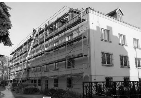
Roboty na budynku zakonnym fot. Hanna Siatka
