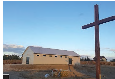
Krzyż w miejscu, w którym stanie kościół. W tle widoczna tymczasowa kaplica – fot. Adam Błaszczak
