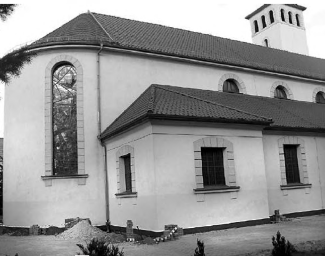
Po zdjęciu kostki pozbrukowej, odkopano fundamenty wokół kościoła fot. Paweł Wolniewicz
