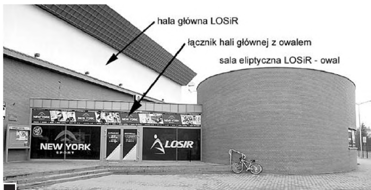
Przednia część hali widowiskowo-sportowej Lubońskiego Ośrodka Sportu i Rekreacji – sala eliptyczna z łącznikiem, za które, w związku z używaniem pomieszczeń bez stosownego pozwolenia na użytkowanie, BMK zapłaciło 45 tys. zł kary fot. Piotr P. Ruszkowski
