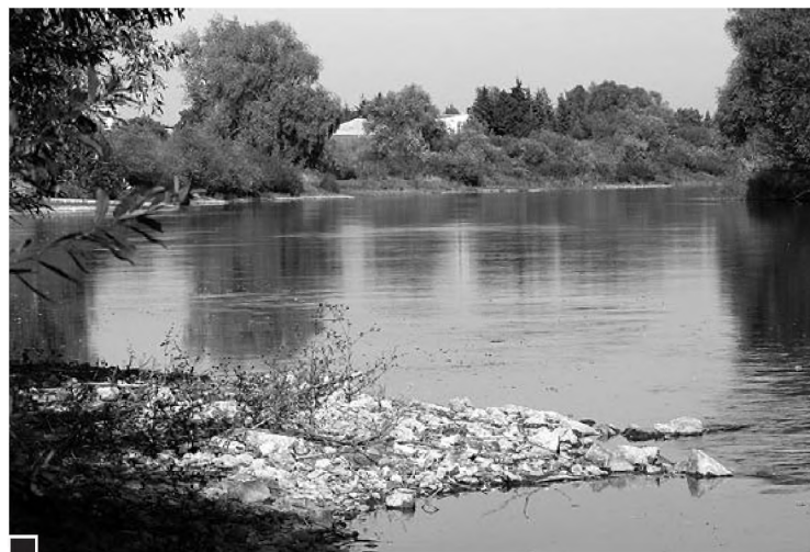
Najlepszym dowodem na bardzo niski poziom Warty są odsłonięte na zakolu rzeki faszyny (usypane z kamieni prostopadle do brzegów półwyspy, by uchronić linie brzegową od podmywania) fot. Paweł Wolniewicz
