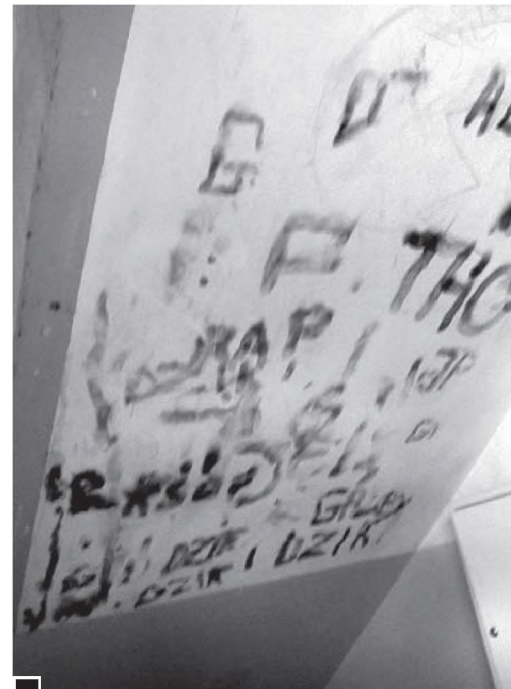
Ściana z wypalonymi napisami – pod schodami prowadzącymi na piętra
