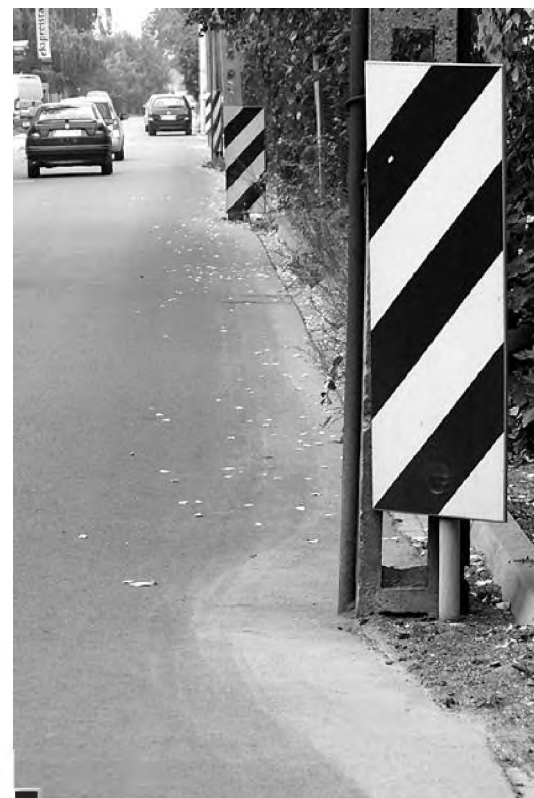
W pasie jezdni ul. Traugutta wciąż tkwią nieprzesunięte słupy energetyczne, a chodnik po przeciwnej stronie miasta wybudowano dopiero na początku 2014 r. (patrz: „WL” 01-2014, str. 12) – koszt: 102 977 zł fot. Hanna Siatka
