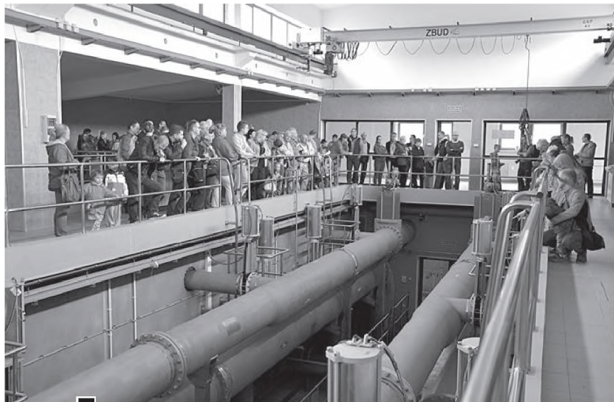
Otwarte drzwi Stacji Uzdatniania Wody w Mosinie fot. Beata Stempczyńska
