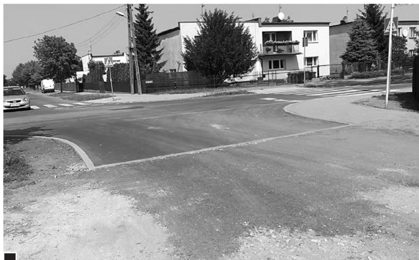
Wjazd z gruntowego odcinka ul. Morelowej w ul. Wojska Polskiego – bezpośrednio na styku z drogą główną zastosowano krawężniki i asfalt, sąsiadujący fragment wyłożono poprzem asfaltowym fot. Hanna Siatka
