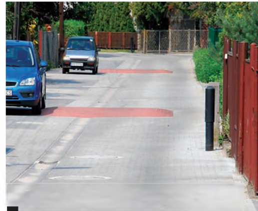
W pasie drogowym znalazły się, niestety, słupki telefoniczne. Po ciemnych śladach opon widać, że przeszkody są wyraźnie omijane fot. Piotr Ruszkowski
