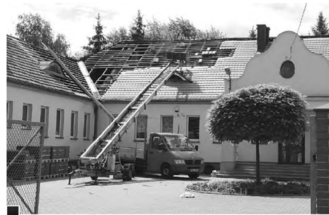
Wymiana starej dachówki karpiówki na nową w Przedszkolu „Tip-Topka Odkrywcy” przy ul. Konarzewskiego (brak informacji o tej inwestycji w oficjalnym wykazie UML) fot. Piotr P. Ruszkowski
