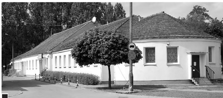
Opisywany obiekt powstały z połączenia budynków – widok od strony wschodniej. Z lewej – cień biurowca Luveny fot. Piotr P. Ruszkowski
