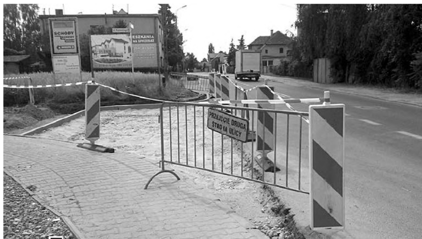
Wjazd ul. Kurowskiego w Sobieskiego. Dzięki zbudowaniu asfaltowego wjazdu nie będą się już w tym miejscu tworzyć dziury. Prace zakończono 15 lipca, a wkrótce rozpoczęto analogiczne działania przy ul. Kalinowej fot. Paulina Sawicka
