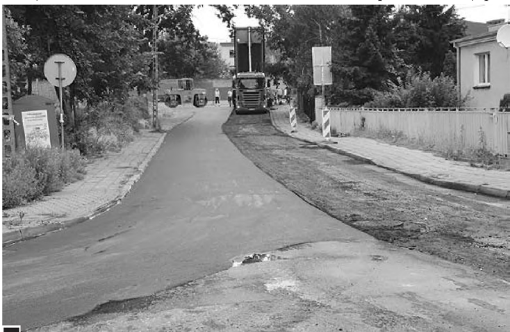
Kompleksowy remont sporego odcinka nawierzchni w ul. 3 Maja, od ul. Armii Poznań do ul. Lemańskiego fot. Piotr P. Ruszkowski
