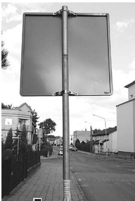
Dospawano rurę i podniesiono znak informujący o przejściu dla pieszych przy SP3 fot. Piotr P. Ruszkowski
