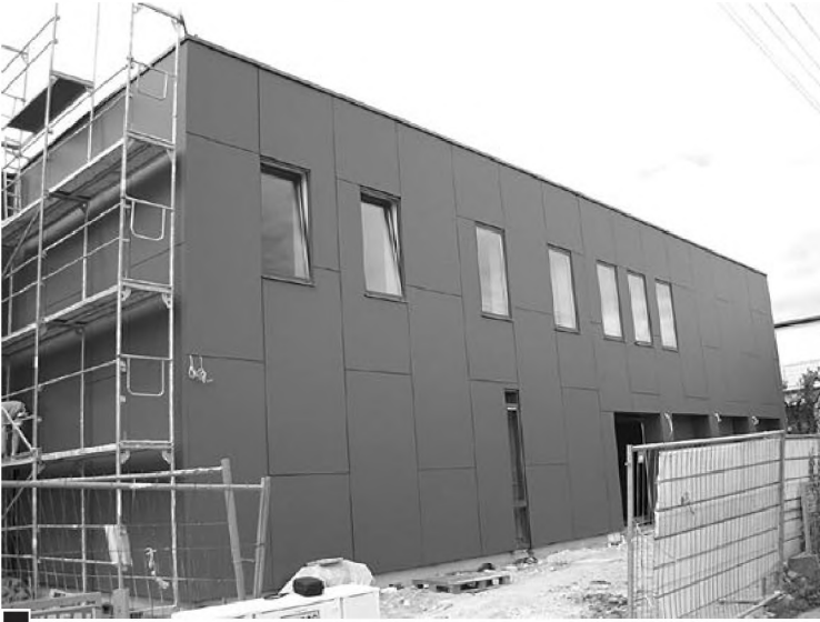
Budowa nowego komisariatu została zakończona. Po wyburzeniu starej siedziby, rusztowania na ścianie frontowej z wejściem od ul. Powstańców Wlkp. zostaną rozebrane fot. Paweł Wolniewicz
