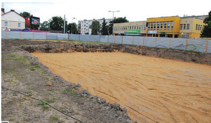
Po przeprowadzonych wcześniej ekspertyzach geologicznych rozpoczęto wykonywanie prac ziemnych. Za cztery miesiące będzie można tu zjeść słynne w całym świecie hamburgery fot. Piotr P. Ruszkowski
