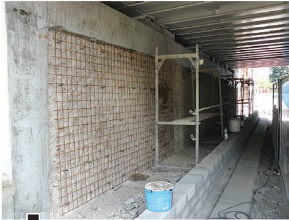
Stare betony, na których posadowiono nową konstrukcję torowiska, wzmocniono stalową kratownicą i otynkowano fot. Paweł Wolniewicz
