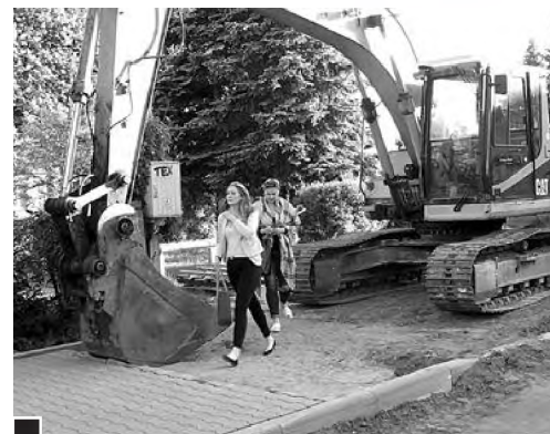
Przed siedzibą komisji wyborczej w Szkole Podstawowej nr 4 trwała budowa ulicy 1 Maja. Przed dniem wyborów wykonawca skończył układanie chodnika metr przed wejściem do szkoły. Wyborcy byli więc zmuszeni przechodzić pomiędzy łyżką koparki a pojazdem fot. Roman Haremza
