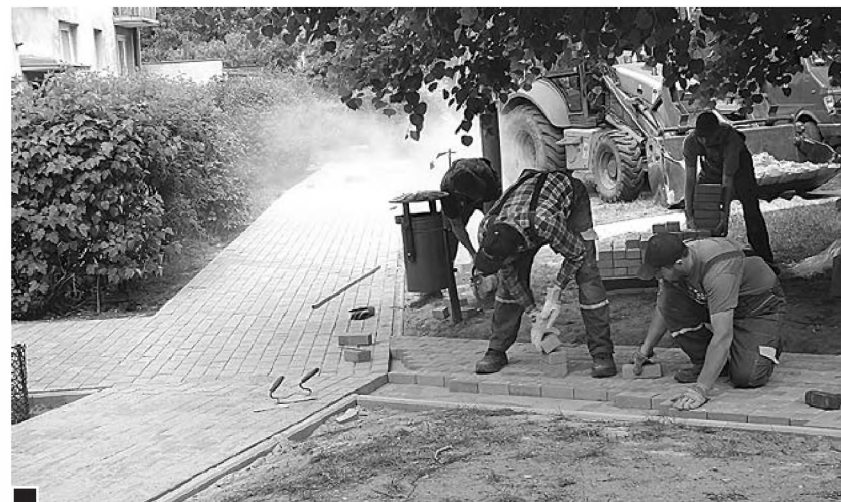
Wymiana chodnika pomiędzy blokiem przy ul. Żabikowskiej 56 i Biblioteką Miejską fot. Hanna Siatka
