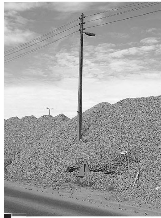
W niektórych miejscach pod tłuczniem zniknęło ogrodzenie mające zabezpieczać jezdnię. Rozrzucony tłuczeń widać też na jezdni. Pod zgromadzonymi kamieniami znika powoli również ostrzegawczy znak drogowy. Słupy tracą pion, co powoduje naprężenie lub rozluźnienie kabli energetycznych fot. Paweł Wolniewicz
