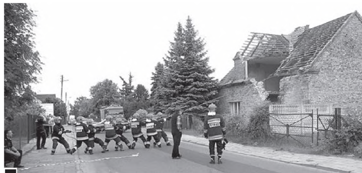
Strażacy z OSP podczas jednej z prób sprowokowania zawalenia się prawostronnej konstrukcji domu. Bezskutecznie w ósemkę ciągną za linę. Akcją kieruje także inspektor nadzoru budowlanego fot. Władysław Szczepaniak
