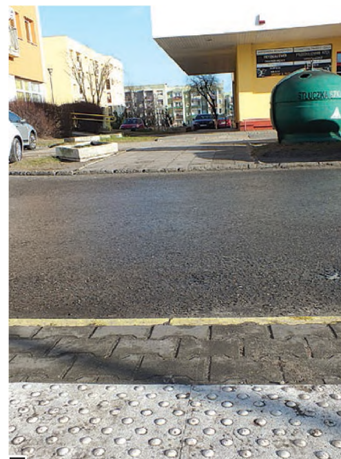
Przeście przez parking do sklepu „Społem” przy ul. Kościuszki. Na pierwszym planie nowe, uwzględniające współczesne standardy zejście z chodnika z porowatymi płytkami informującymi niewidomych o bliskości jezdni. W głębi nieprzyjazny, kruszący się krawężnik przy Społem fot. Hanna Siatka
