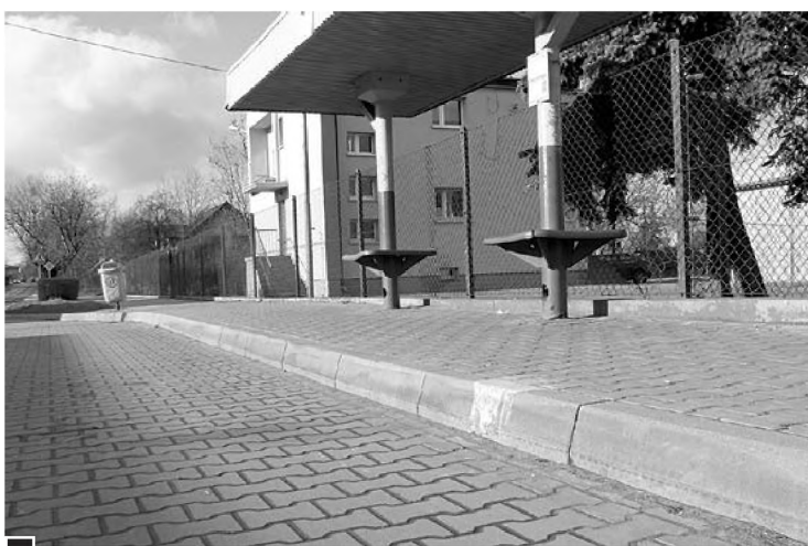
Poprawny – wysoki – peron na przystanku przy ul. Fabrycznej, ułatwiający osobom na wózku oraz starszym dostanie się do autobusu. Podobnych jest w Luboniu coraz więcej. Żeby tylko ci, którym te udogodnienia mają służyć, mogli z nich korzystać (właściwy podjazd autobusu) fot. Hanna Siatka
