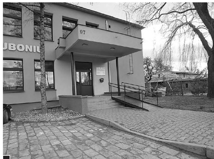
Metalowa równia z poręczami przy Ośrodku Kultury i przyjazny krawężnik nowego chodnika od strony parkingu (niestety wciąż wyboistego) fot. Hanna Siatka
