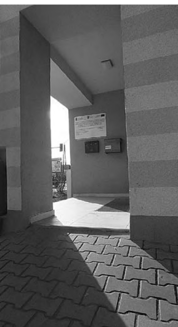
Wąski podjazd do Biblioteki Miejskiej z progiem, pomiędzy budynkiem i filarem fot. Hanna Siatka
