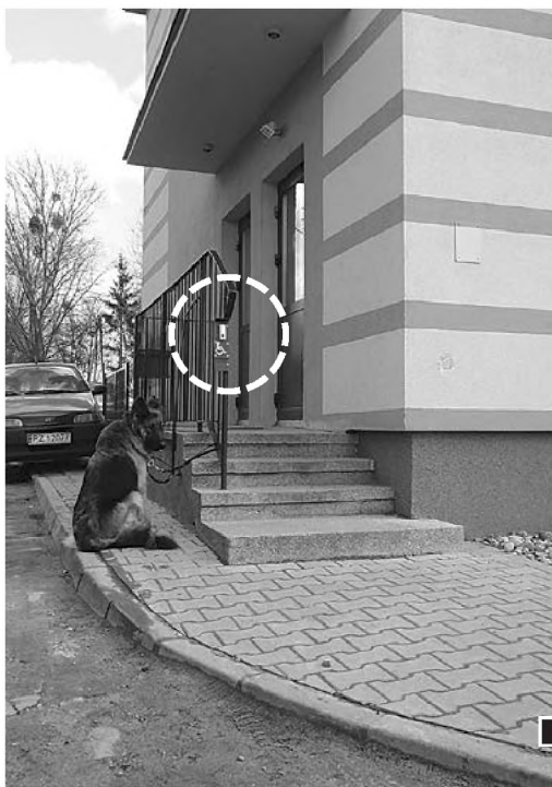
Absurd budowlany sprzed 10 lat – niedostępny podjazd do placówek położonych na przyziemiu bloku nr 53 przy ul. Kościuszki – z wysokim krawężnikiem fot. Hanna Siatka
