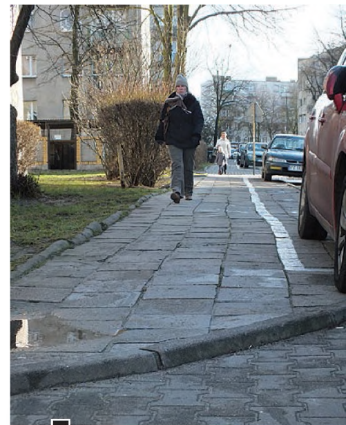
Spróbujmy wsiąść na wózek inwalidzki i podjechać pod ten krawężnik – jeden z wielu w Spółdzielni Mieszkaniowej „Luboniarka”. Nic dziwnego, że niezliczni „zmotorzowani” niepełnosprawni, których spotykamy na naszych ulicach, poruszają się po jezdniach fot. Hanna Siatka
