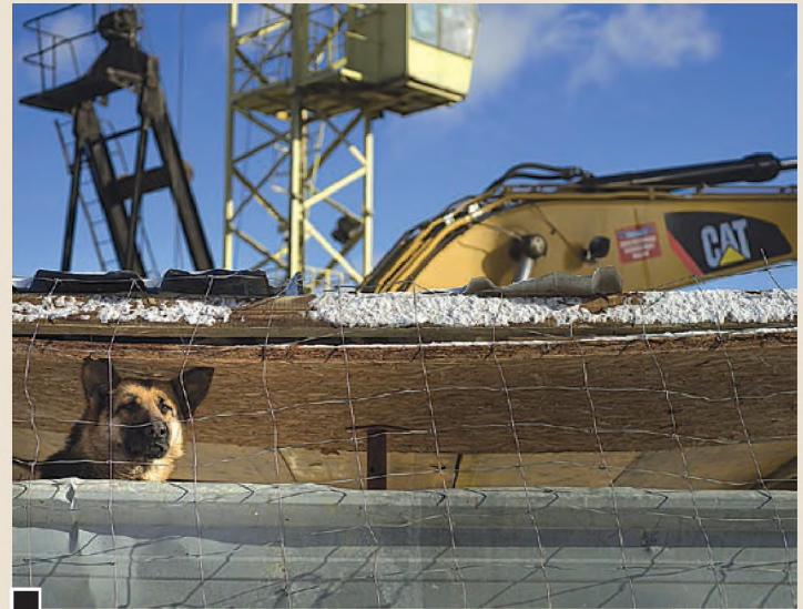
Pilnujący placu budowy przy ul. Wschodniej owczarek niemiecki strzeże wielkiego, żółtego kota (CAT-a – sprzętu budowlanego) fot. Mariusz Marszałkiewicz
