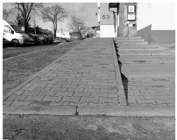
Absurd budowlany sprzed 10 lat – niedostępny podjazd do placówek położonych na przyziemiu bloku nr 53 przy ul. Kościuszki – z wysokim krawężnikiem fot. Hanna Siatka
