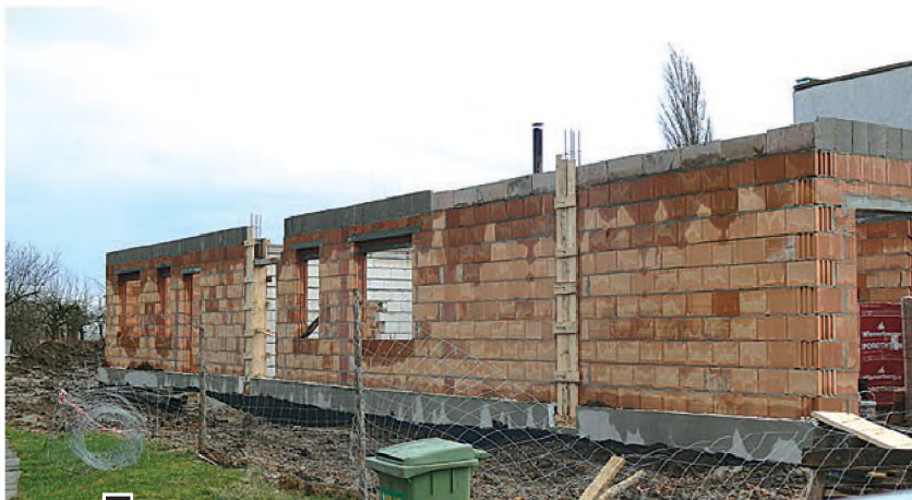
Lokale przy ul. Pułaskiego w trakcie budowy fot. Agata Samol
