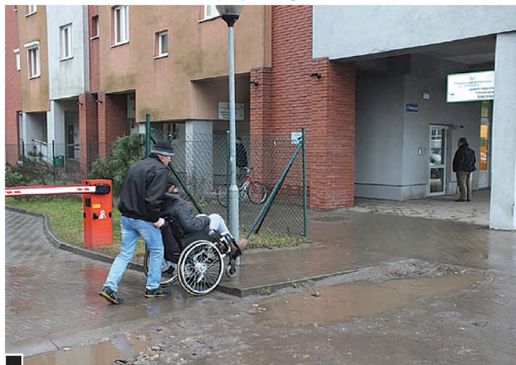
Ten wózek z osobą niepełnosprawną był pchany wyboistą i błotnistą aleją Jana Pawła II. Przed dotarciem do podjazdu przy Przychodni Lekarza Rodzinnego z adresem: ul. Wschodnia 25 (w głębi zdjęcia z lewej) musiał jeszcze pokonać sterzcący krawężnik, nierówny „chodnik” i kolejne kałuże fot. Hanna Siatka
