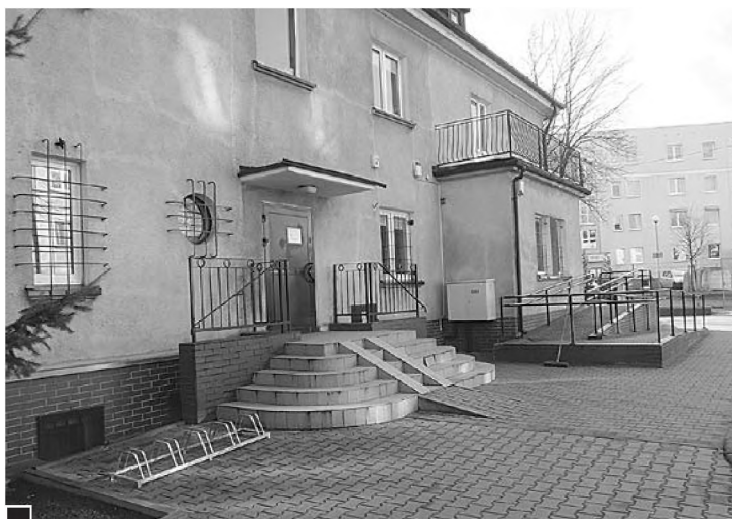
Infrastruktura przy Miejskim Ośrodku Pomocy Społecznej: utwardzone obejście, poprawny, dwupoziomowy podjazd z poręczami, schody, po których można wciągnąć wózek dziecięcy oraz stojaki na rowery fot. Hanna Siatka
