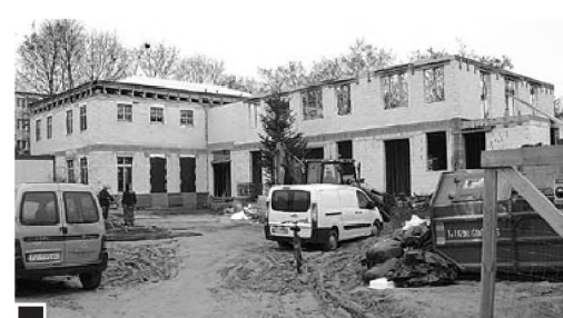
Dzięki sprzyjającej aurze prace związane z budową przebiegały pomyślnie. Przed końcem 2014 r. stan surowy Domu Parafialnego był gotowy fot. Paweł Wolniewicz
