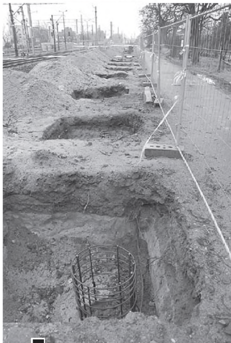
■ Ciąg fundamentów pod przyszłe filary ekranów akustycznych przy chodniku ul. Dworcowej fot. Piotr P. Ruskowski
