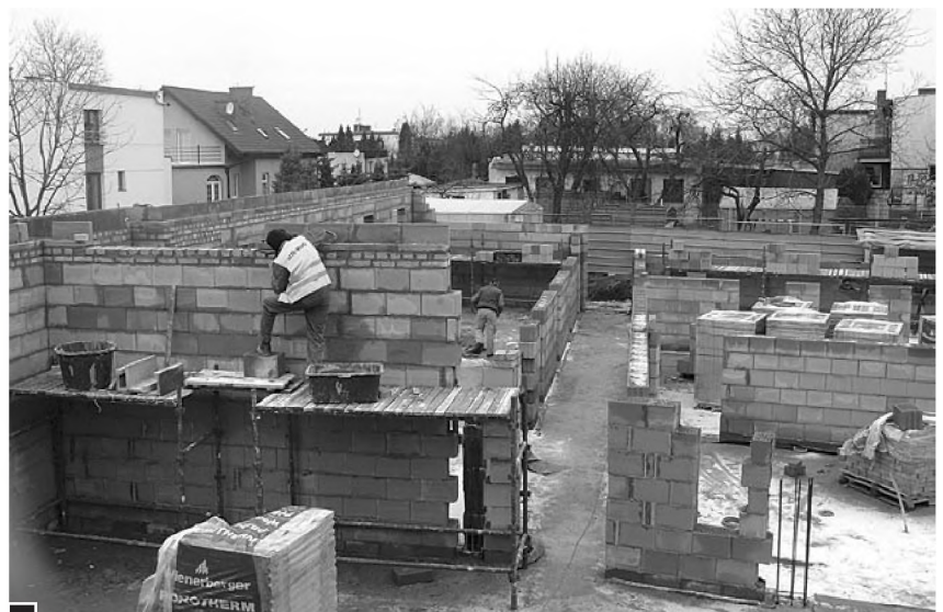
Niezależnie od pogody na budowie praca wre. Po stronie zachodniej ułożono betonowe elementy, na których zostanie osadzony strop fot. Paweł Wolniewicz
