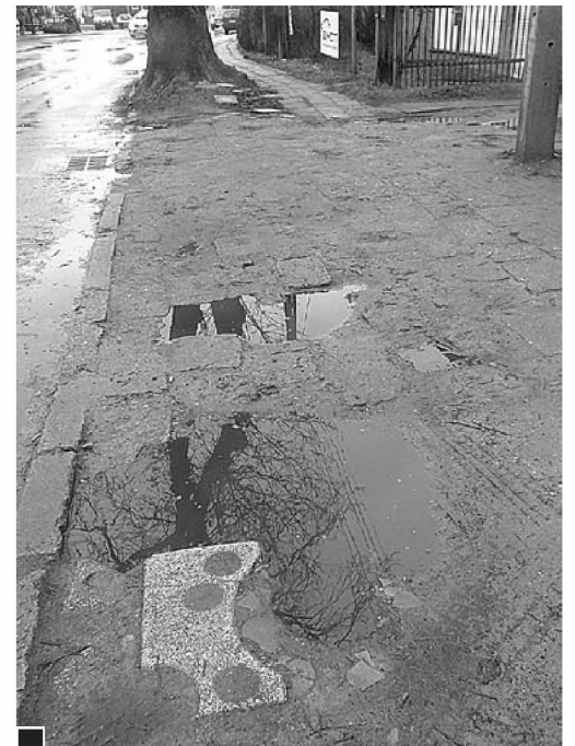
Chodnik na ul. Kościuszki w rejonie ul. Mickiewicza – ubytki próbuje się uzupełniać czym się da. W głębi – za wysokimi krawężnikami bocznej ulicy (często występujące w pasie ul. Kościuszki) potrzaskane płyty i wąski przesmyk dla przechodniów fot. Hanna Siatka
