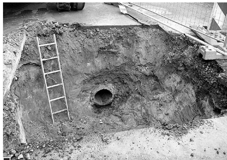
W ul. Okrzei na wysokości ul. Cieszkowskiego wykopano dziurę w której znajduje się nowa studnia rewizyjna. W następnym etapie stąd zostanie pociągnięty kanał deszczowy w kierunku ul. Wschodniej fot. Paweł Wolniewicz
