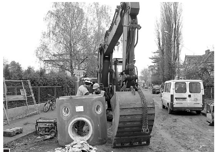
W miejsce starych studni rewizyjnych na ul. Cieszkowskiego montuje się nowe o większej średnicy fot. Paweł Wolniewicz
