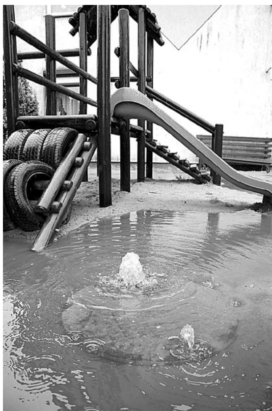
Aquanetu obiecali, że na posesji, gdzie jest największy napór ścieków, który wypycha klapę studzienki, będzie zamontowany specjalny, szczelny zakręcany właz.
