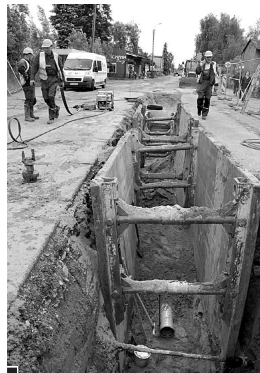
Budowę kanalizacji w ul. Sobieskiego realizują 3 brigady. Trwa układanie rury o średnicy 200 mm na głębokości 2 – 3,5 m na odcinkach: od ul. Topolowej do Kurowskiego, od Kurowskiego do Walki Młodych (na zdjęciu) i od ul. Walki Młodych do 1 Maja fot. Piotr P. Ruskowski
