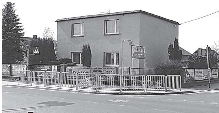
Feralne miejsce, w którym zamontowano barierki wygrodeniowe. Na elewacji domu jednorodzinnej widoczne ślady po ostatnim wypadku (20 lutego br.) w którym jeden z pojazdów staranował ogrodzenie i zatrzymał się na posesji przy ul. Sobieskiego 20 fot. Paweł Wolniewicz
