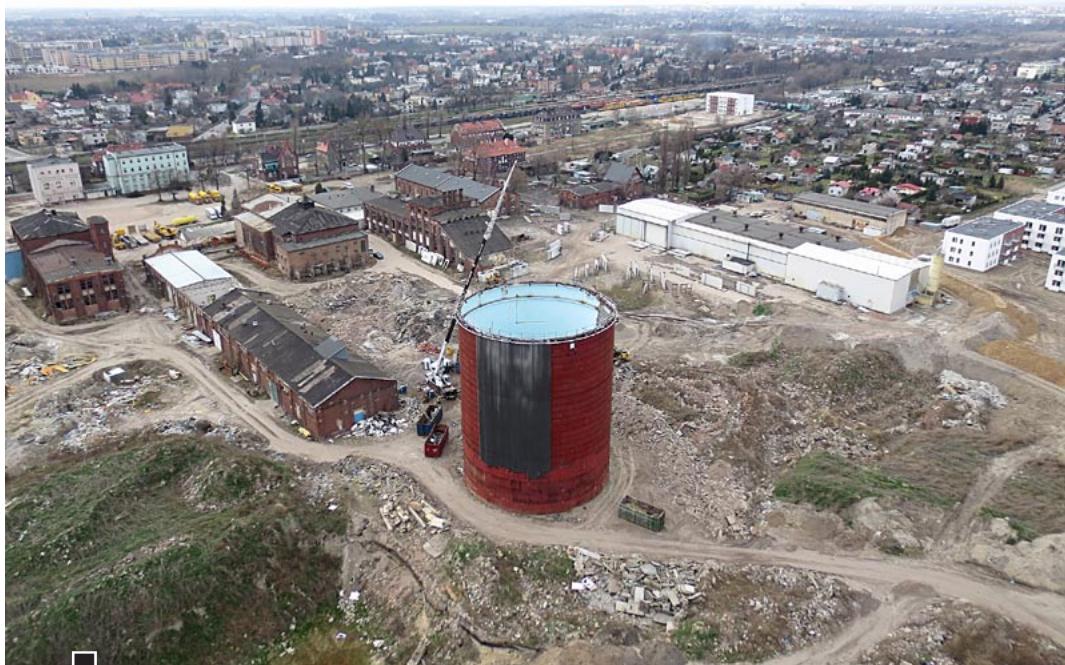
095k Jedno z ostatnich ujęć stalowego silosu – magazynu krochmalu po dawnych Zakładach Ziemniaczanych – podczas rozbiórki. Od frontu widać resztę zewnętrznej powłoki z aluminiowej blachy falistej. W kolorze czerwonym – przeciwkorozyjny podkład z farby miniowej. Z prawej – fabryka domów należąca do firmy Pajo (białe zabudowania), obok bloki III etapu budowy osiedla „Warta Park”, jasny budynek w głębi to pierwszy z kompleksu hoteli przy skrzyżowaniu ul. Armii Poznań i 3 Maja. Z lewej, z czerwonej cegły – zabytkowa zabudowa byłych Zakładów Ziemniaczanych fot. Rafał Wojtyński
