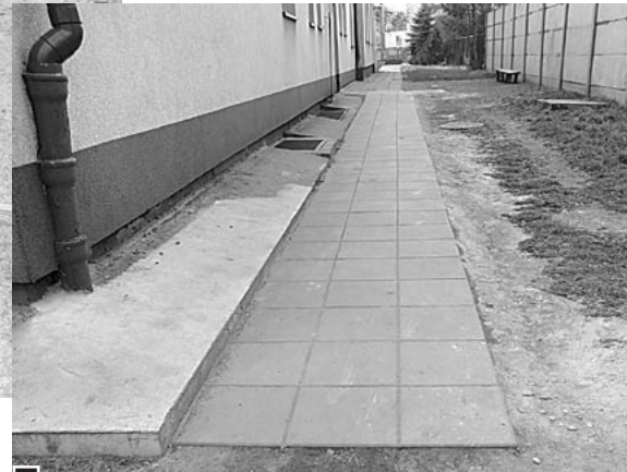
Nowy chodnik i naprawiona betonowa opaska wokół budynku fot. Hanna Siatka
