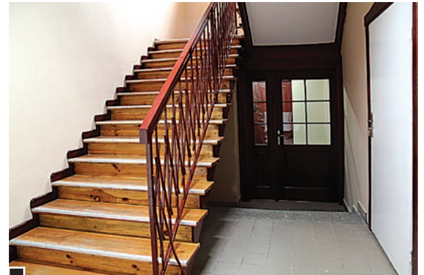
Odremontowana klatka schodowa i schody
