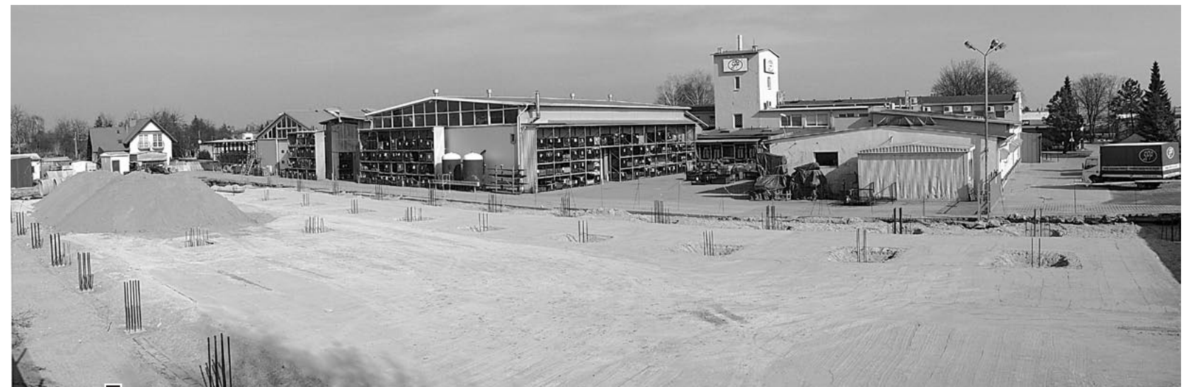
Plac budowy, na którym wkrótce stanie funkcjonalna i przestronna hala magazynowo-produkcyjna z zapleczem socjalnym dla pracowników oraz nowoczesny biurowiec – widok z parkingu Intermarké fot. Paweł Wolniewicz
