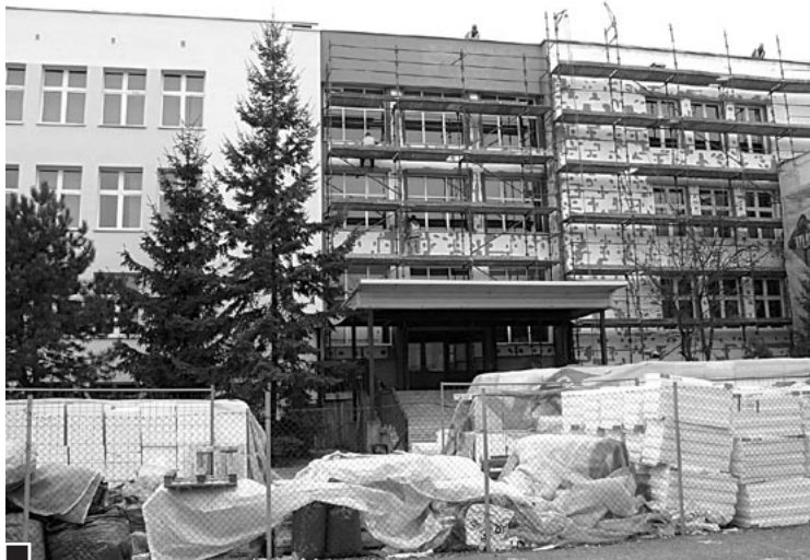
Ocieplanie ściany budynku Gimnazjum nr 1 – widok od strony wschodniej fot. Paweł Wolniewicz
