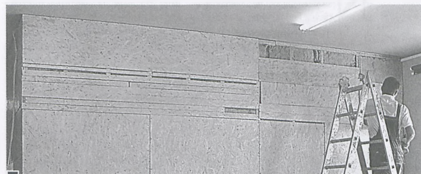
Zbliżenie ze zdjęcia, na które wskazał mieszkaniec miasta. Z takich listewek płyty OSB zbudowano część ściany działowej w SP 3 fot. Paweł Wolniewicz
