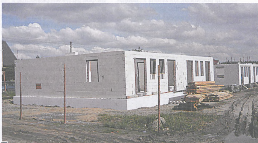
Ściany dwóch spośród 10 budynków, które powstaną przy ul. Kurowskiego – stan z 30 września fot. Paulina Sawicka
