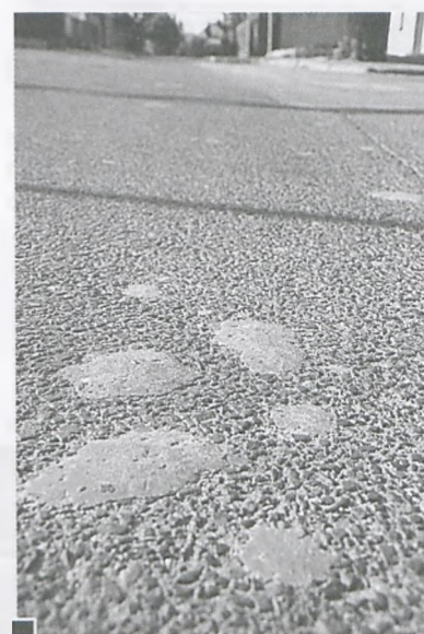
Wprasowane przez samochody w asfalt grudy gliny przez wiele dni nanoszone przez wywrotki na ul. 3 Maja. Niesprzątane powodowały wyboistość drogi oraz niebezpieczeństwo poślizgów podczas opadów fot. Piotr P. Ruszkowski
