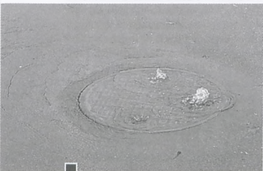
Ze studzienek rewizyjnych pod naporem, woda wydostaje się nawet z instalacji na jezdnię fot. Rafał Wojtyniak
