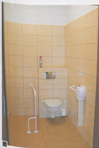
Ubikacja przystosowana do potrzeb osób niepełnosprawnych fot. Paweł Wolniewicz
