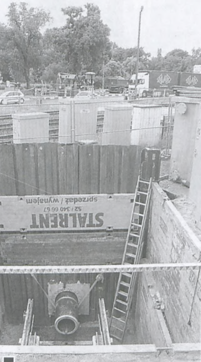
Widok z ul. Dworcowej przy przejeździe PKP na wysokości Zakładów Chemicznych. Na głębokości ok. 4 m pod ziemią wprowadzono kolektor ceramiczny. Jego wyjście znajduje się 50 m dalej – w parku, obok pomnika Siewcy fot. Piotr P. Ruskowski
