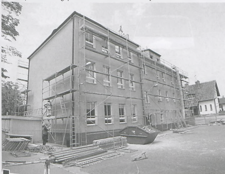
Prace przy przebudowie dachu w SP 1 fot. Hanna Siatka
