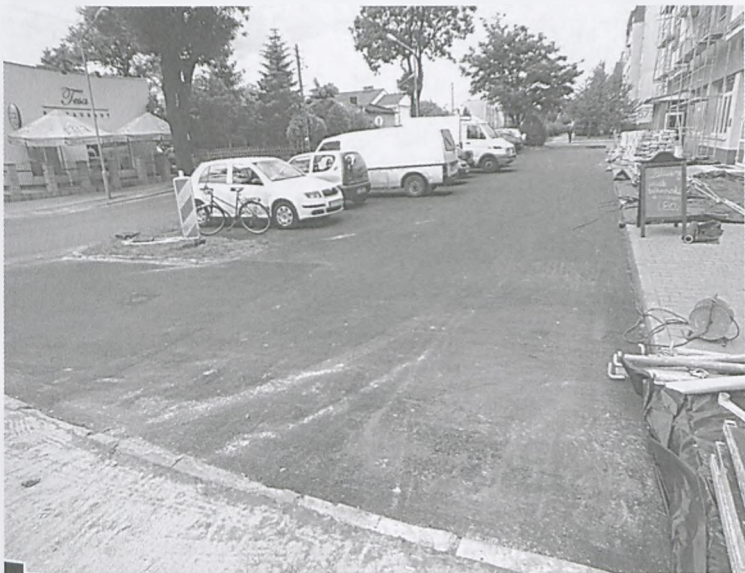
Parkingi przy ul. Kościuszki (przed blokami 51 i 53) z nową, asfaltową nawierzchnią wykonaną w ramach naprawiania lubońskich ulic fot. Hanna Siatka
