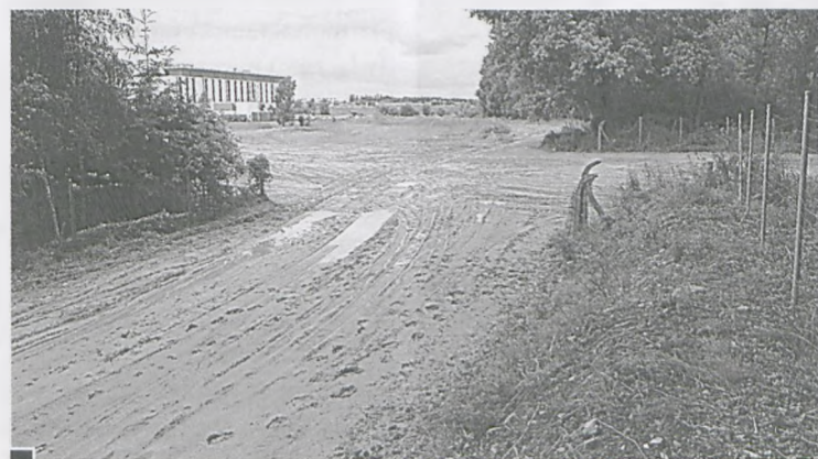
Równany w ostatnim czasie teren pomiędzy ul. Dąbrowskiego i Krańcową tuż przy płocie miejsca ujęcia wody należącego do Aquanetu fot. Rafał Wojtyński
