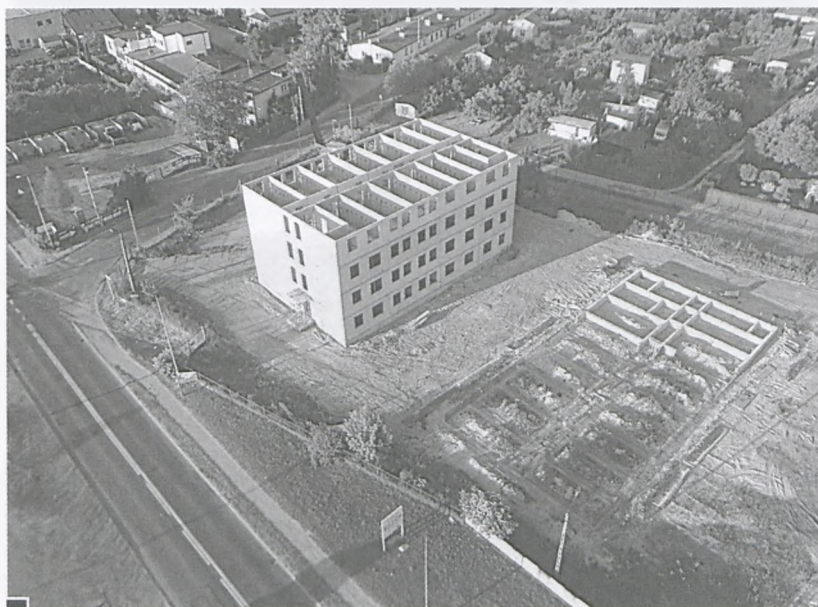
Trwa budowa kompleksu 3 hoteli realizowanych przy skrzyżowaniu ulic Armii Poznań i 3 Maja. Hotele buduje firma „Pajo” z przeznaczeniem na mieszkania i nie tylko (według planów, w tym miejscu przewiduje się rondo dla drogi 430). Na zdjęciu wykonanym z góry – gotowa bryła jednego z hoteli. Wyraźnie widać układ i wielkości poszczególnych mieszkań. Drugi budynek „wychodzi” już z fundamentów fot. Rafał Wojtyński
