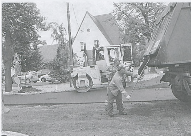
Układanie nowej warstwy ścieralnej asfaltu o deklarowanej grubości 5 cm fot. Hanna Siatka
