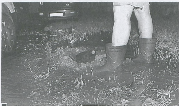
Fekalia zmieszane z deszczówką, pomimo obciążenia, unoszą klapę studzienki rewizyjnej i z niemałym impetem zalewają posesję przy ul. 3 Maja 1 a ściekami z całej okolicy, wlewając się też częściowo do piwnicy fot. Piotr P. Ruszkowski
