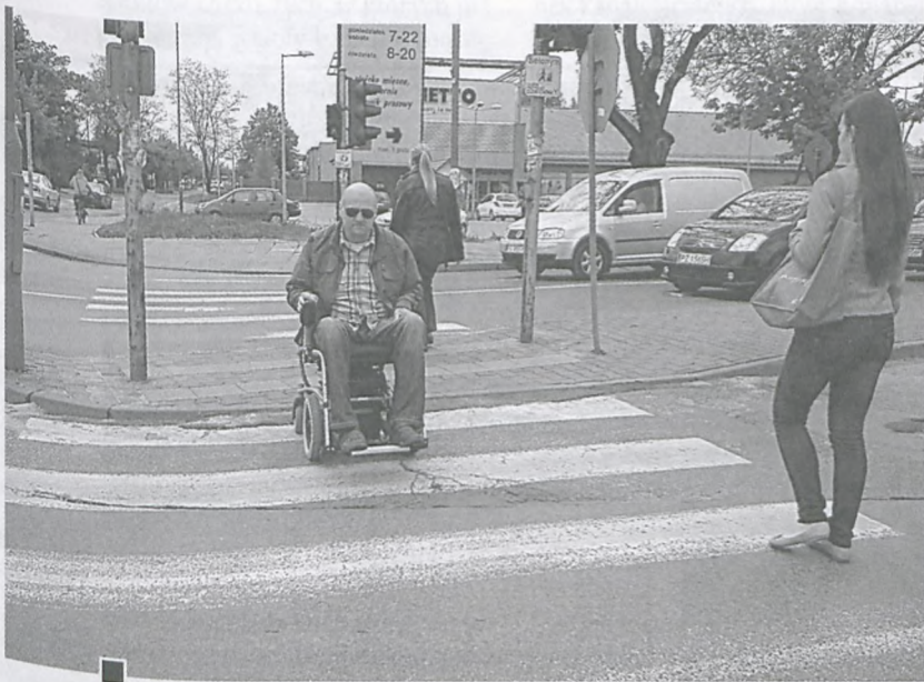
Przebudowane, łatwiejsze do pokonania krawężniki na przejściu przez skrzyżowanie ul. 11 Listopada i Kościuszki z Żabikowską (okolice Netto)
