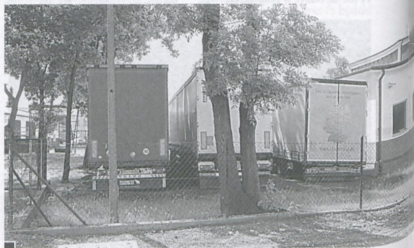
Tuż przy pomieszczeniu energetycznym (z prawej), przed którym jeszcze w ubiegłym roku rosły piękne klony (wycięte z wątpliwego powodu – korzenie przeszkadzały w podziemnej instalacji energetycznej). Zaraz po ich likwidacji (jesienią 2012 r.) nawieziono poprez i zorganizowano dodatkowy parking dla tirów fot. Piotr P. Ruszkowski
