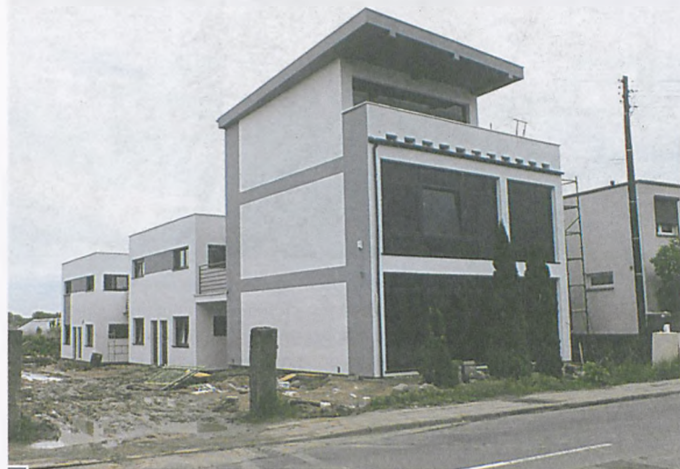
Okazały obiekt biurowo-mieszkalny Akropolu przy wjeździe do Lubonia ulicą Kościuszki fot. Hanna Siatka
