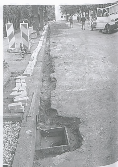
Wyrównywanie poziomu studzienek kanalizacji deszczowej i układanie rynsztoku fot. Hanna Siatka
