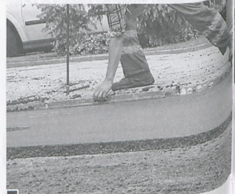
Badanie spadków asfaltu w kierunku studzienek. Pierwszy większy deszcz pokaże, czy dywanik został położony prawidłowo fot. Hanna Siatka
