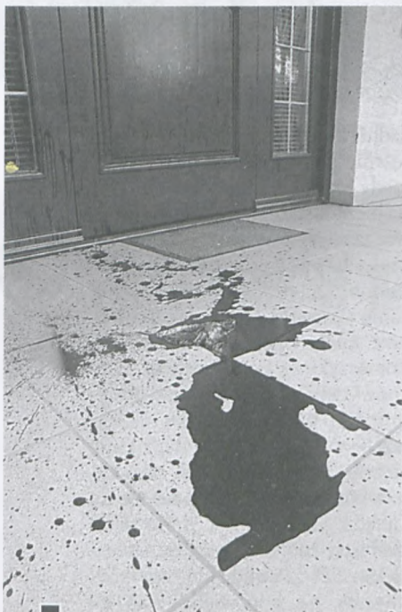
Tak wyglądało wejście do domu po zamachu przeprowadzonym późnym wieczorem, 22 maja. Oprócz schodów wejściowych ochlapana farbą została elewacja w kilku miejscach i drzwi fot. Piotr P. Ruszkowski
