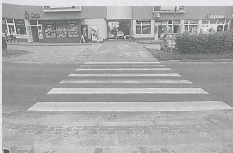
Przykład przebudowanego, przyjaznego dla pieszych i niepełnosprawnych przejścia przez ul. Kościuszki. Dla wózków obniżono krawężniki, a dla słabowidzących przed wejściem na jezdnię zamontowano specjalne, żółte, trwałe pasy z żółtego betonu (niemalowane) z wypustkami fot. Hanna Siatka
