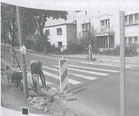
Likwidacja barier – obniżanie krawężników i układanie pozbruku w zdewastowanych miejscach przez Kom-Lub – na ul. Kościuszki fot. Hanna Siatka
