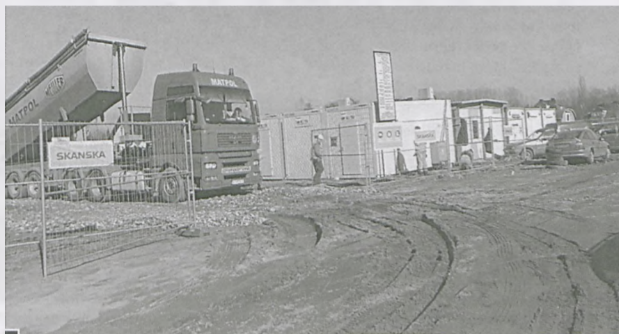
By wyrównać i utwardzić grunt, na teren bazy firmy Skanska trzeba było nawieźć kamienie fot. Hanna Siatka
