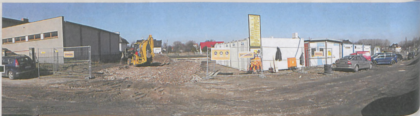
Budowa zaplecza inwestycji przy ul. Topolowej – początek marca fot. Hanna Siatka
