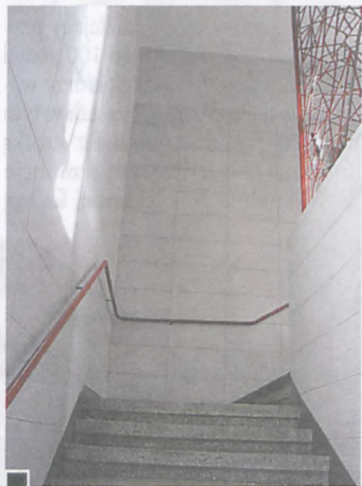
Ściany klatki schodowej wyłożono płytkami grysowymi, a lastrykowe schody przeszlifowano fot. Paweł Wolniewicz
