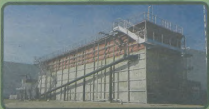
Fermenter odpadów biodegradowalnych służący do produkcji biogazu
