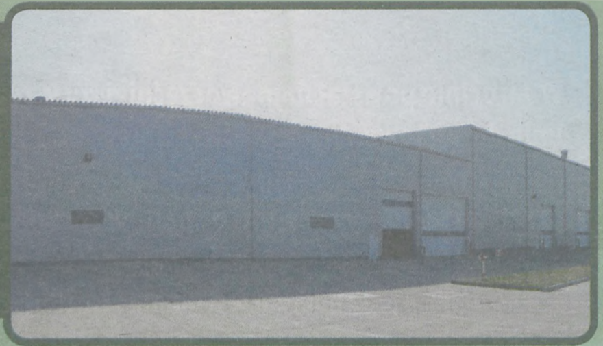
Hala segregacji mechanicznej odpadów komunalnych
