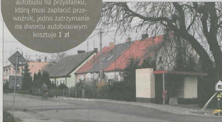
Gmina przejmując zarządzanie przystankami przy drogach powiatowych zobowiązana będzie do ponoszenia kosztów ich utrzymania i remontów
