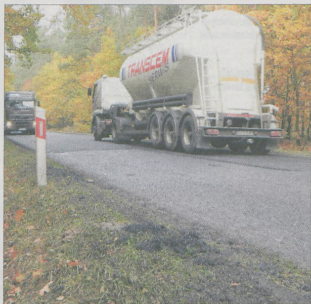
Droga z Tarzec do granicy z gminą Kotlin w trakcie remontu
