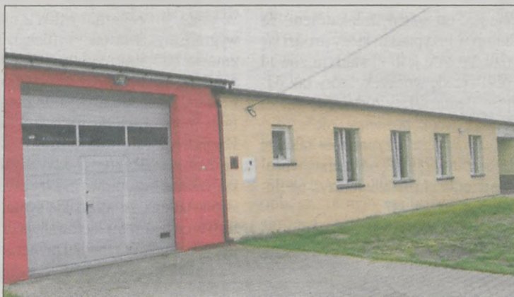
Oprócz ocieplenia dachu, planuje się wydzielenie pomieszczenia na kotłownię oraz położenie kostki brukowej przed budynkiem
