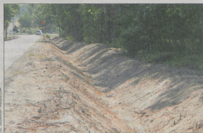
Nowe rowy od strony drogi krajowej nr 12
