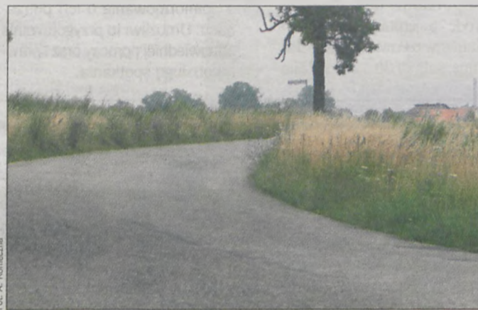
Zarośnięte skrzyżowania i zakręty dróg powiatowych są szczególnie niebezpieczne dla poruszających się po nich kierowców
