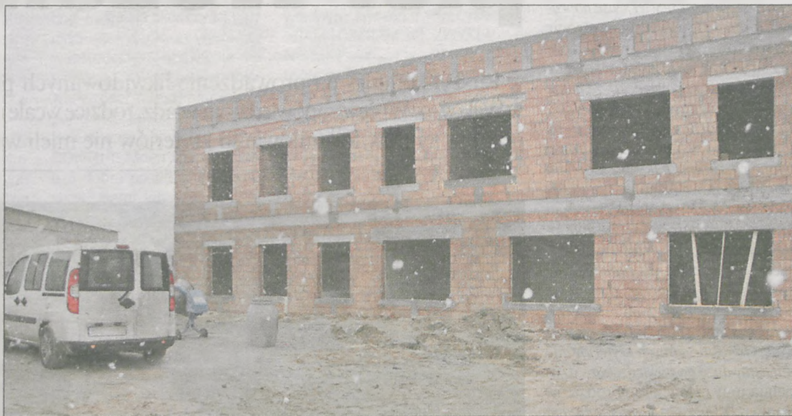
W ubiegłym tygodniu pogoda nie była sprzymierzeńcem budowlanców
