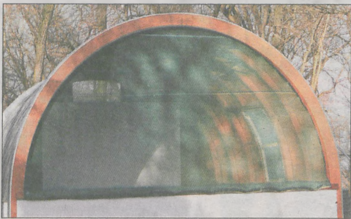
Siatka zamontowana na jaraczewskiej scenie ma chronić przed deszczem, śniegiem i liśćmi
