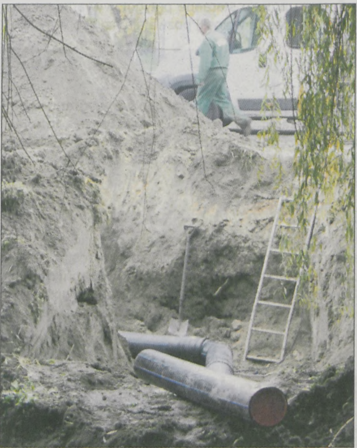
Do końca listopada ma trwać kładzenie rurociągu
