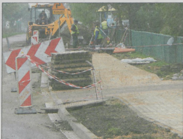
Przed weekendem zakończono układanie chodnika
