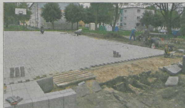
Dziurawą asfaltową powierzchnię zastąpiła kostka brukowa
