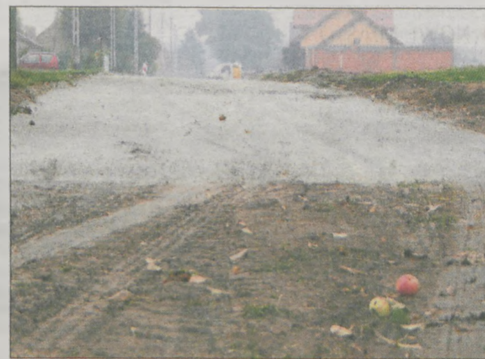
Na gruntowej drodze w Zalesiu w najbliższym czasie położona zostanie nawierzchnia asfaltowa
