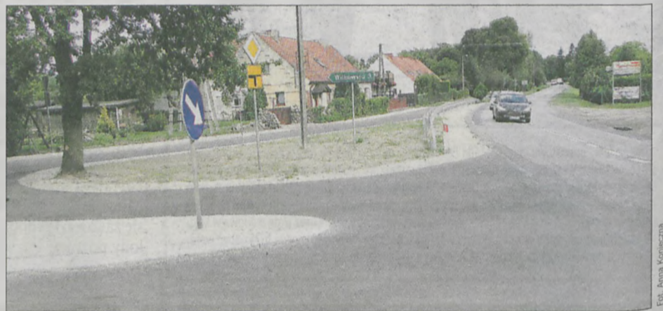
Jarocińskie Linie Autobusowe twierdzą, że po przebudowie skrzyżowania w Tarcach autobusy nie mogą dojechać do przystanku. Z kolei Wielkopolski Zarząd Dróg Wojewódzkich w Poznaniu, który zlecał roboty, uważa, iż skrzyżowanie zostało tak przebudowane, że ułatwia ruch pojazdów
