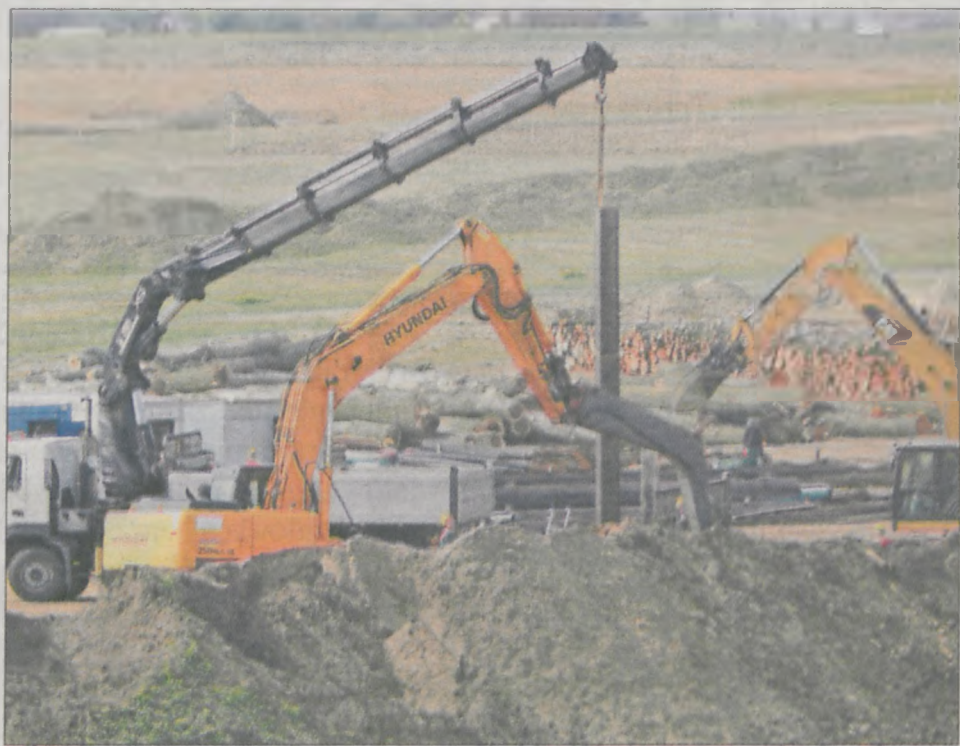
Na teren przyszłego zalewu wjechał ciężki sprzęt
