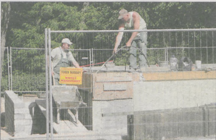
Budowlancy z firmy PBH Marzyński mają termin do końca lipca na zmodernizowanie sceny w parku
