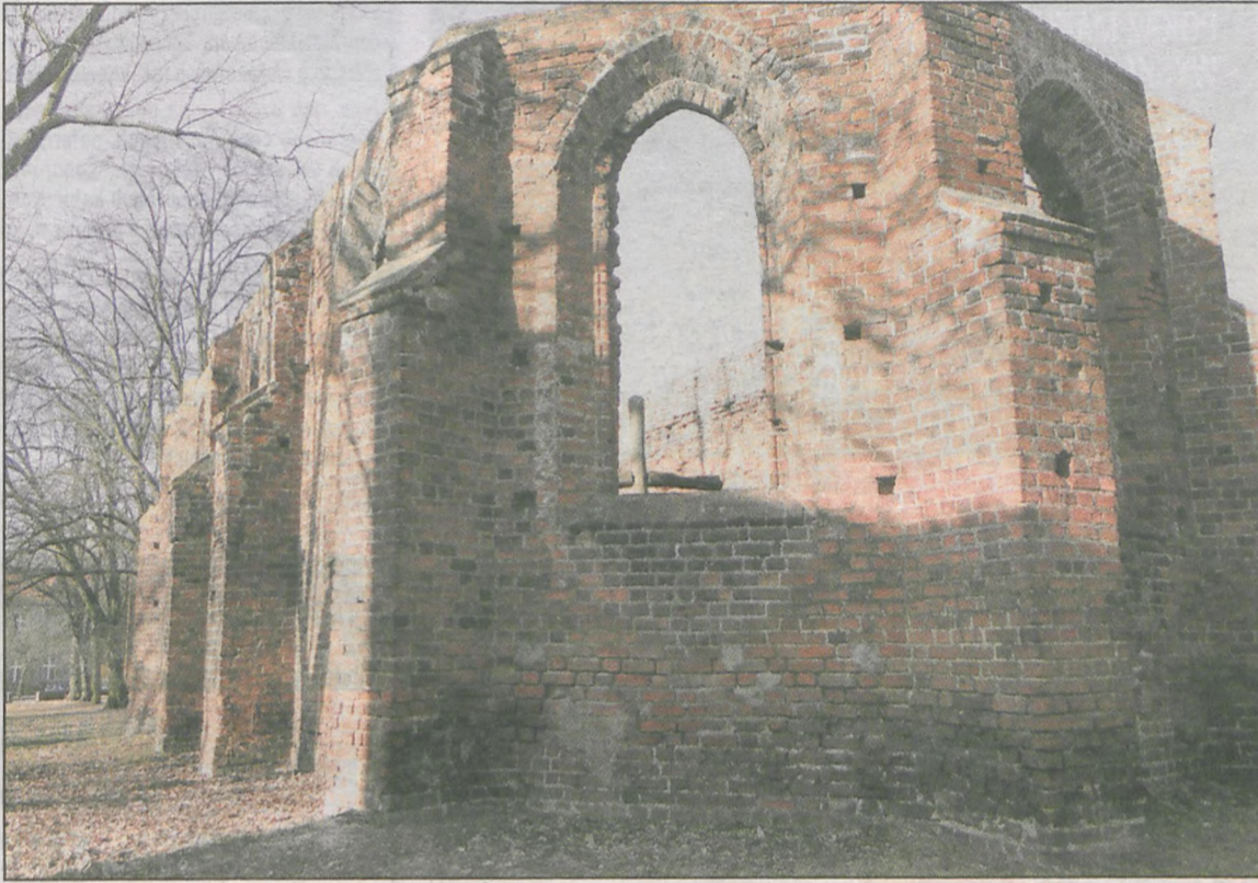
Z otoczenia kościoła zostało usuniętych kilka drzew, których korzenie uszkadzały fundamenty
