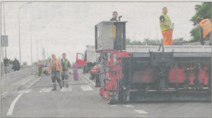
Drogowcy z ciężkim sprzętem wrócili na wiadukty
