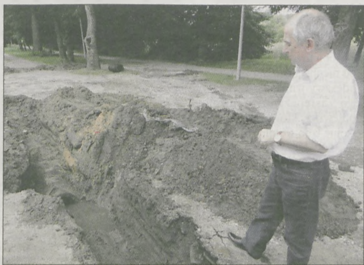
Dyrektor Komunalnego Zakładu Budżetowego w Jaraczewie nadzoruje prace przy udrażnianiu rur w pobliżu strzelnicy
