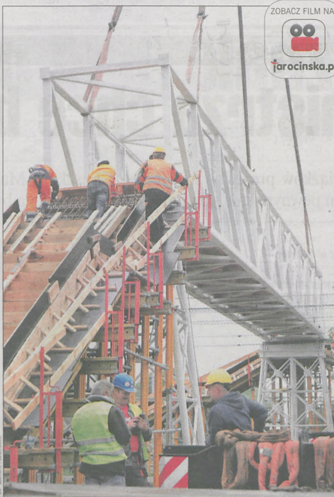
Nową kładkę ustawiono nad torami kolejowymi
