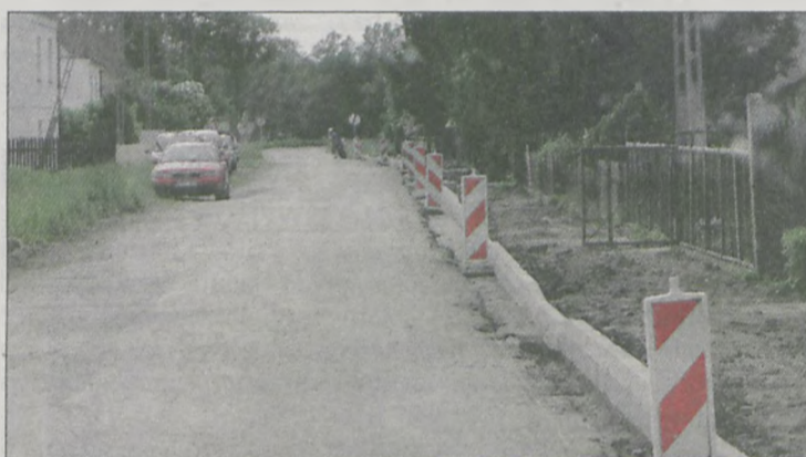
Kilkanaście dni mają drogowcy na skończenie przebudowy drogi w Lisewie
