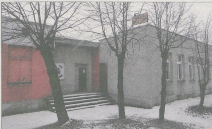
Dzięki pozyskanemu przez gminę dofinansowaniu, sala wiejska w Goli przejdzie generalny remont, a w Rusku i Paręczewie powstaną nowe świetlice
