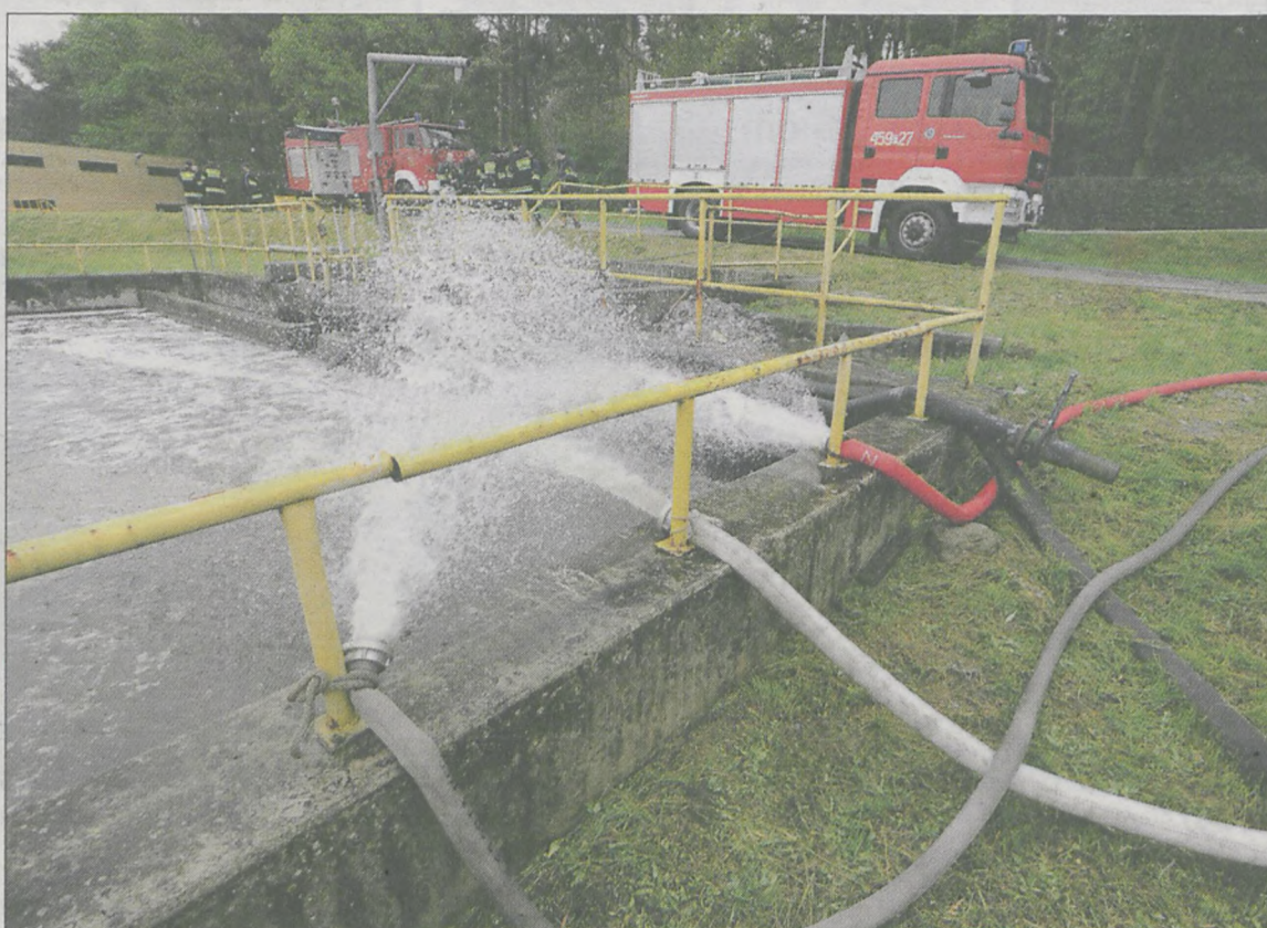
W czwartek strażacy walczyli z pękniętym kolektorem w Cielczy
