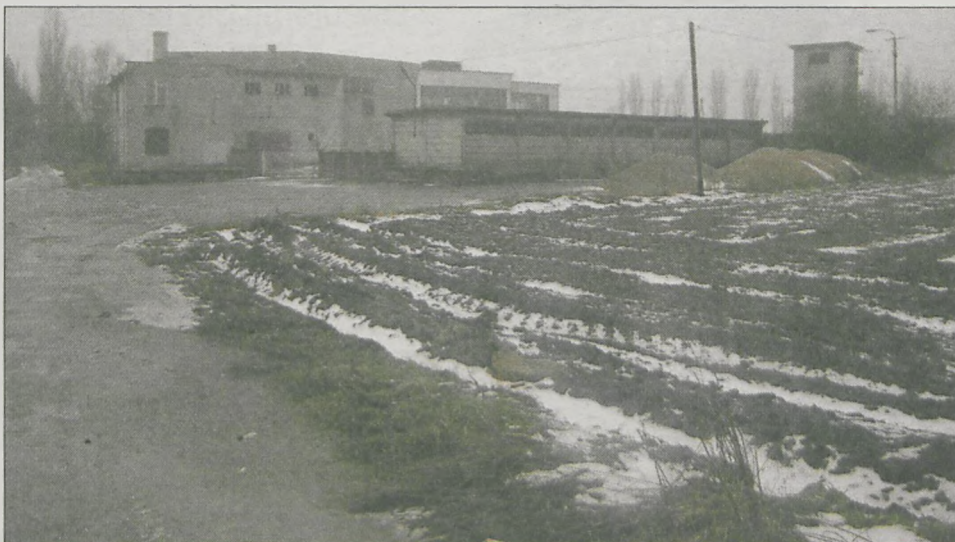
Budynki, które znajdują się na terenie byłej betoniarni zostaną wyburzone. Na ich miejscu powstanie lądowisko dla helikopterów ratownictwa medycznego
