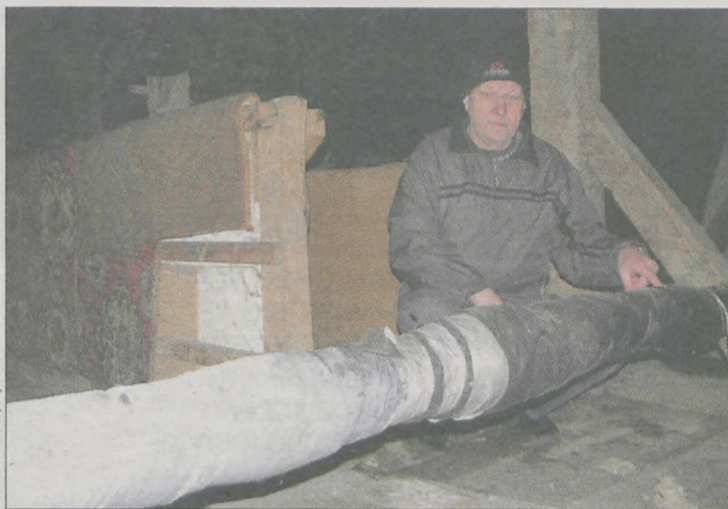
Rura biegnie nieocieplonym poddaszem
