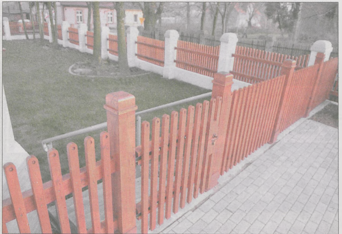
„Urobek uzyskany z wycinki drzew został zużyty do produkcji elementów wymagającego remontu ogrodzenia wokół przedszkola publicznego” - napisał burmistrz Jacek Jędraszczyk. Nie trzeba być fachowcem, by się przekonać, że na oplotownie zużyto zaledwie kilka metrów sześciennych drewna.
