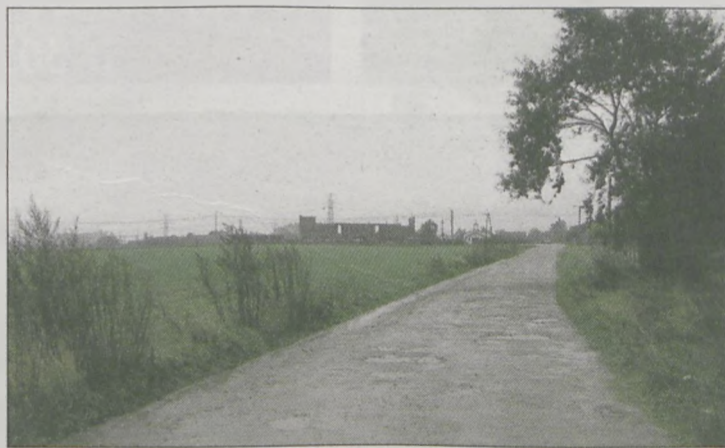
Przebudowa drogi gminnej Jarocin - Roszków (od ul. Folwarcznej w Jarocinie) powinna się rozpocząć w przyszłym roku
