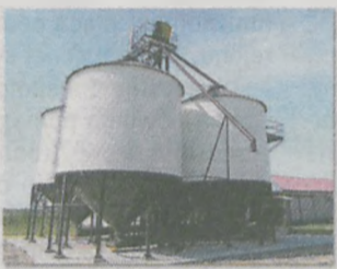
Linie technologiczne magazynów zbożowych
