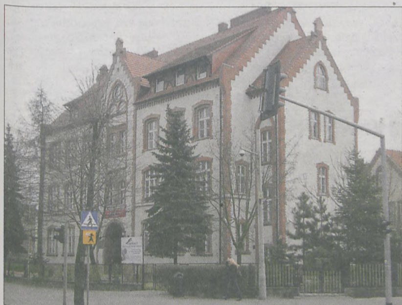
Działka, na której stoją budynki SP nr 2 i hali sportowej, ma być objęta hipoteką zabezpieczającą kredyt JTBS
