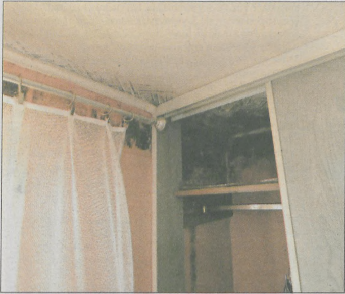
Tak wyglądają pomieszczenia na górnej kondygnacji bloku nr 3 w Kamieniu
