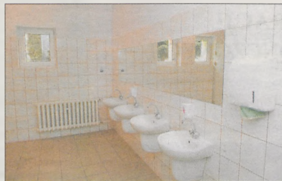
W łazienkach, które są na każdym poziomie, położono nowe płytki i zainstalowano armaturę. Roboty pochłonęły 168 tys. zł
