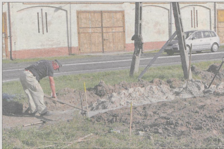
(era) Pracownicy interwencyjni układali m. in. chodnik przy krajowej 11 w Kotlinie
