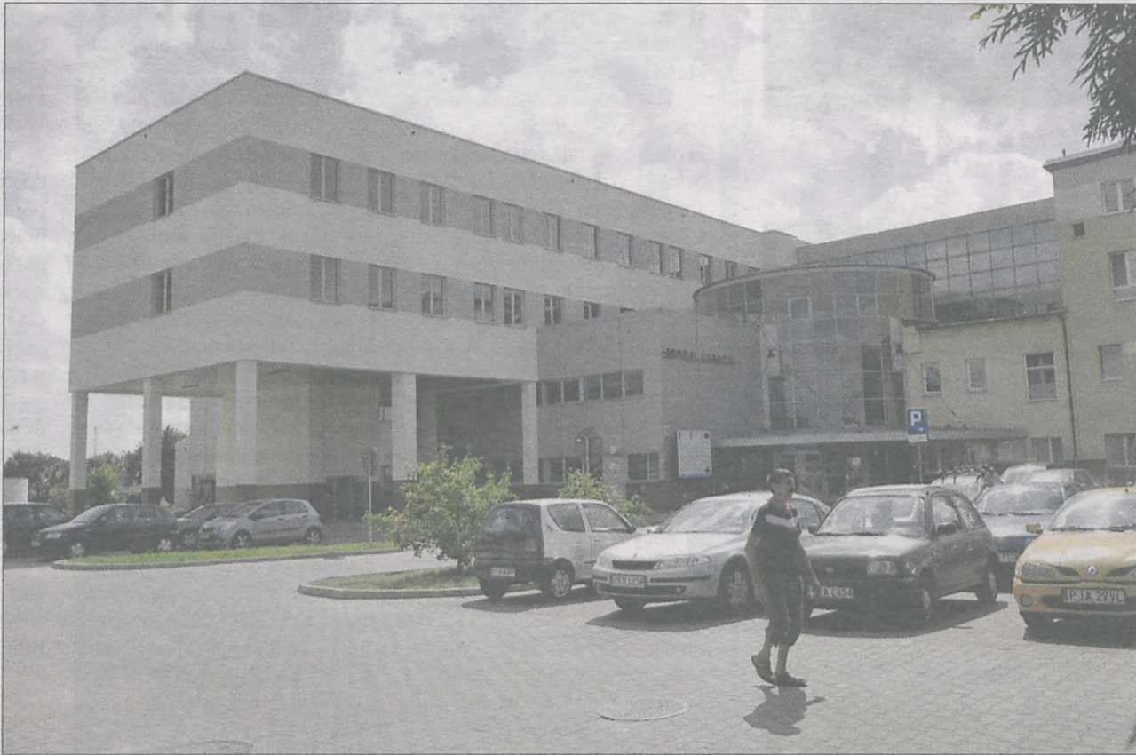
Nie wiadomo, kiedy nowa część szpitala zostanie oddana do użytku. Prezes Jantas twierdzi, że przyczyna leży po stronie wykonawcy. Ten z kolei obwinia szpital
