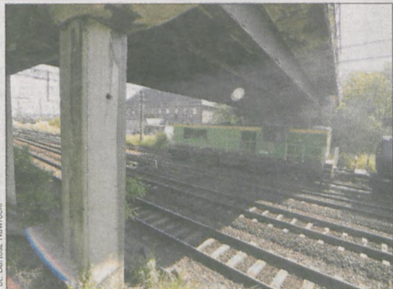
Jeśli powiat otrzyma wsparcie ministerstwa infrastruktury w sfinansowaniu przebudowy wiaduktów, to roboty ruszą jeszcze w tym roku
