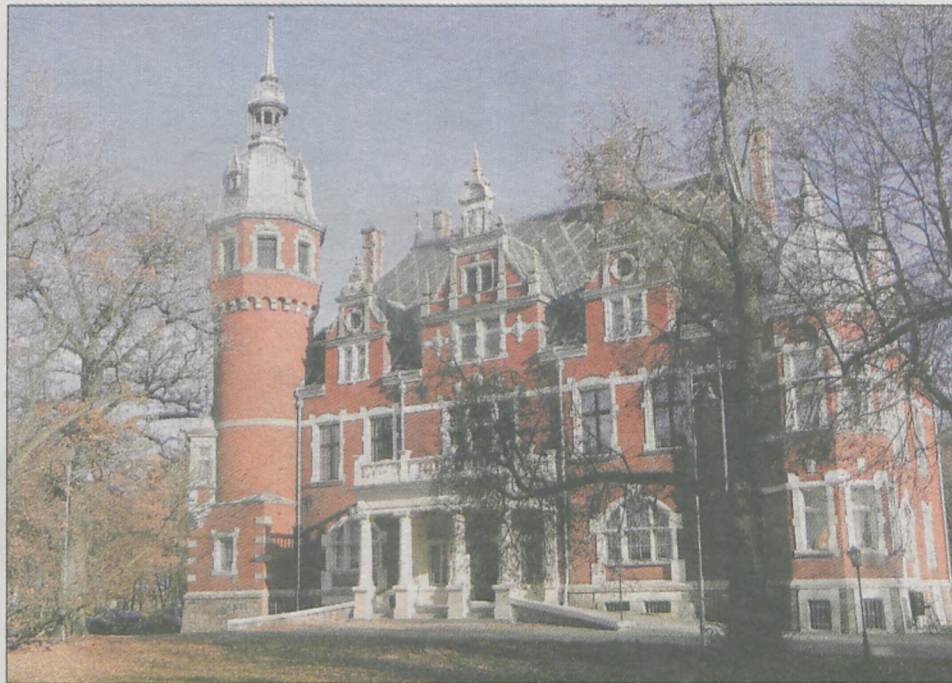
Uszkodzenia dachu na pałacu w Zakrzewie w czasie ostatniej zimy spowodowały zamknięcie dwóch sal - pracowni i sali mieszkalnej. Trzy osoby przeniesiono do innych pomieszczeń
