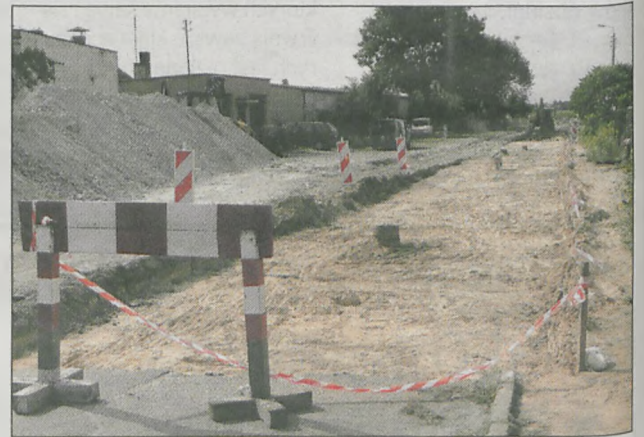
Drogowcy przygotowują sporą warstwę podbudowy pod drogę w Śmiełowie
